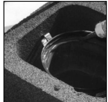
8. Нанесите на верхнюю кромку ёмкости для сбора и отвода конденсата достаточное количество герметика Rotemplo.
