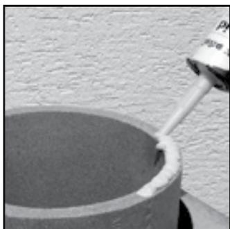
45. На верхний край керамической трубы нанесите герметик Rotempro и установите конус.
