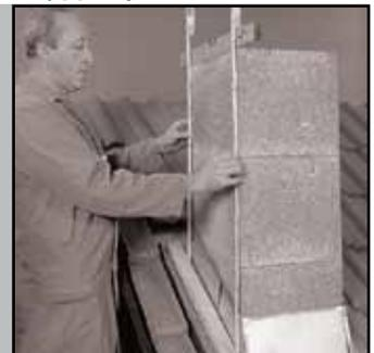
36. Наложите рейки толщиной около 3 см на верхнюю часть готовой каменной оболочки дымоходной трубы и снимите требуемые размеры до выполненной конструкции крыши.
