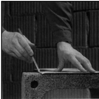
6. На следующей каменной оболочке начертите отверстие для дверцы, размеры которого уточните по габаритам дверцы, входящей в комплект поставки.
