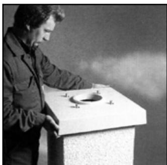
41. Установите лёгкую покрывную плиту так, чтобы в отверстиях появились арматурные стержни.
