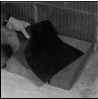
1. Подготовьте основание высотой до уровня будущего чистого пола. На готовое основание положите гидроизоляцию.
