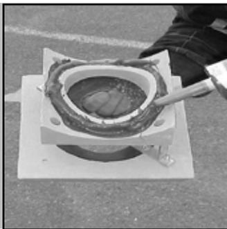
26. На внутреннюю часть элемента для подключения потребителя обильно нанесите герметик Rotempro.
