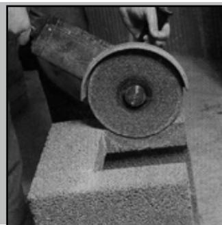
20. Угловой шлифовальной машиной вырежьте отверстие.
