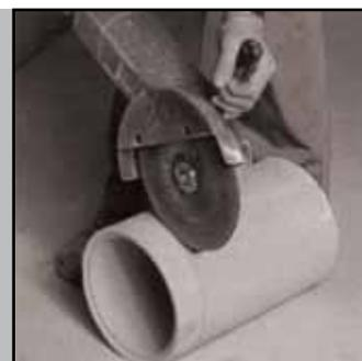
44. Обрежьте керамическую трубу угловой шлифовальной машиной, после чего очистите оба конца трубы от пыли. Обильно нанесите на трубу герметик Rotempro и установите её на место.
