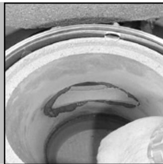
27. Установите элемент для подключения потребителя в отверстие, заполните образовавшиеся щели, избытки герметика удалите
