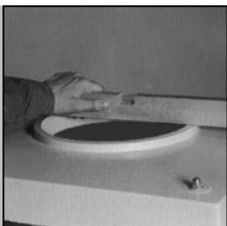
42. Положение покрывной плиты проверьте уровнем.
