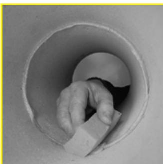
18. Удалите избыточное количество герметика Rotempro с внутренней поверхности трубы при помощи влажной губки или специальной лопатки.
