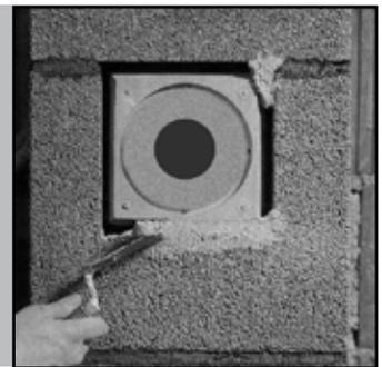
28. Заделайте раствором оставшиеся зазоры, следя за тем, чтобы раствор не попал во внутреннюю часть дымохода. Продолжите монтаж в стандартной последовательности.
