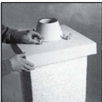
46. Закрепите покрывную плиту при помощи винтов.
