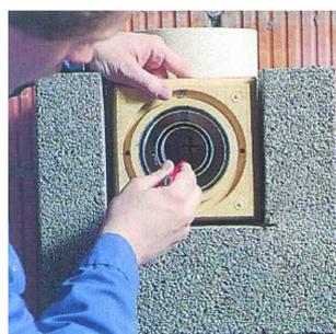
23. Установите керамическую трубу внутри каменной оболочки и обозначьте на сухой поверхности трубы место подключения потребителя. Керамическую трубу с меткой выньте для дальнейшей обработки.
