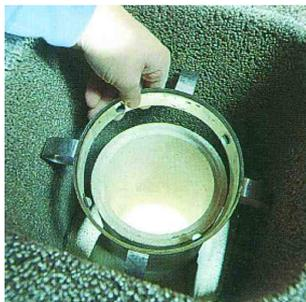
14. Установите распорное кольцо на внутреннюю керамическую трубу. Два последующих соединения труб закрепляются манжетой для обеспечения дополнительной прочности и газоплотности, затем вновь устанавливается распорное кольцо и т.д.
