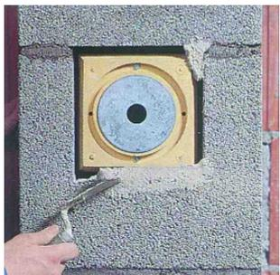
30. Заделайте раствором оставшиеся зазоры, следя за тем, чтобы раствор не попал во внутреннюю часть дымохода. Продолжайте монтаж в стандартной последовательности.
