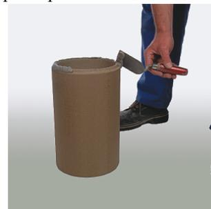
18. Нанесите на верхнюю кромку керамического элемента достаточное количество массы для заделки швов
