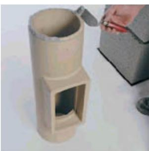
11. Нанесите на верхнюю кромку керамического элемента достаточное количество массы для заделки швов
