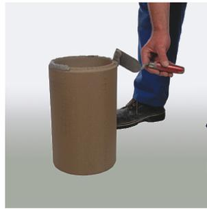
45. Минимальная температура для работы с массой для заделки швов +5°C. Для обеспечения данной температуры необходимо использовать нагревательные приборы которые защитят соединенные элементы труб от мороза до застывания.
