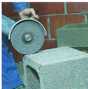
7. Вырежьте размеченное отверстие под ревизионную дверцу в каменной оболочке угловой шлифовальной машиной.
