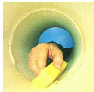
20. Удалите избыточное количество склеивающей массы с внутренней поверхности трубы при помощи влажной губки или специальной лопатки. Операции описанные в пунктах с 14 по 20 повторить до точки подключения прибора.
