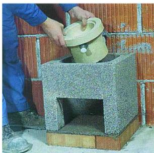
5. Установите ёмкость для сбора и отвода конденсата в центре блока. Ориентация и подключение отвода конденсата ёмкости, выполняется в соответствии с проектом.
