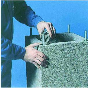
37. Залейте жидким раствором каналы с установленными арматурными стержнями. Стержни в канале должны быть отцентрированы, чтобы раствор занял всё необходимое пространство.
