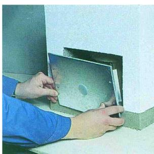
35. После затвердевания штукатурки закройте отверстие для отвода конденсата нижней заглушкой.
