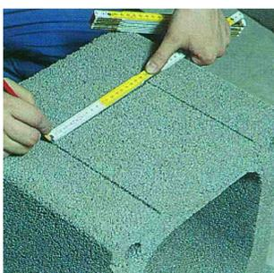
21. Отметьте на каменной оболочке отверстие размером 20 x 20 см для Подключения потребителя. Положение и ориентация отверстия должны соответствовать проекту.
