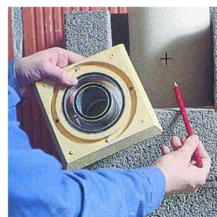
24. Выполните в керамической трубе отверстие Ø 112 мм при помощи буровой коронки. Допускается выполнять отверстие в трубе не только круглой, но и квадратной формы (рис. 25).
