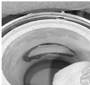
29. Установите элемент для подключения потребителя в отверстие, заполните образовавшиеся щели, избытки герметика удалите.
