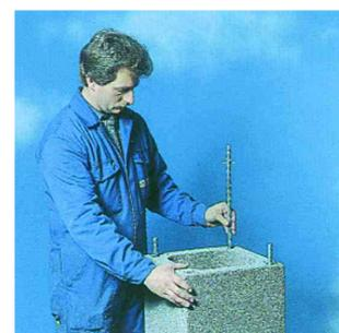
36. При высоте дымохода над крышей более 1,0 м. выполняется дополнительное усиление конструкции дымохода арматурными стержнями, для противостояния ветровым нагрузкам. Вставьте арматурные стержни в специальные каналы. Количество стержней определяется проектом.
