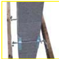
Schiedel držalo dimnika - izvedba med špirovci
