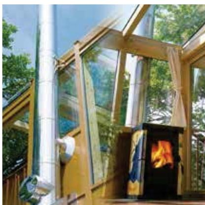
Sistema camino marcato CE denominato **KERASTAR**, a doppia parete in ceramico refrattario supersottile e acciaio inossidabile, coibentato con lana di roccia ad alta densità ed elevato spessore; studiato per ogni impianto di tipo civile o industriale e per ogni combustibile, per funzionamento sia a secco (D) che in condensazione (W). **Ideale per legna e biomassa ma anche per impianti a condensazione, grazie alla designazione "GW3".**
