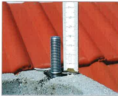
11. A merevítő-rögzítő csavar max. 4 cm-t állhat ki a felső síktól.
