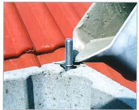
12. A furatban elhelyezett csavarokat a készlethez vödörben adott híg cementhabarccsal kiöntjük.
