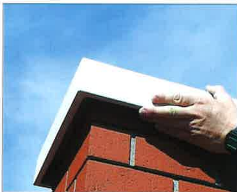
14. A könnyűbeton fedkővet felhelyezzük.
