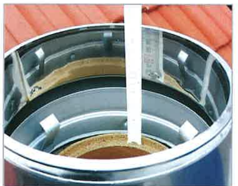
18. A torkolati kúpot szárazon elhelyezzük, lemérjük az utolsó samottcső hosszát a kúp felső síkjáig és a csövet méretre vágjuk.
