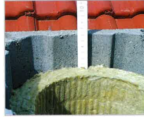
9. A Schiedel UNI kéményfej elemeket a szükséges magasságig építjük. Az utolsó hőszigetelőlapot úgy vágjuk vissza, hogy a teteje 6 cm-rel alacsonyabban végződjön, mint az utolsó Schiedel UNI kéményfej elem felső síkja.
