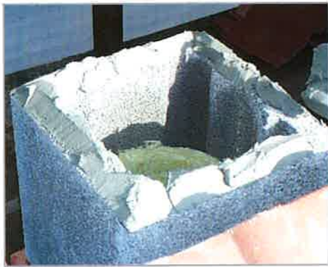
1. A kéményépítéshez használt H10 falazóhabarcsot az utolsó köpenytéglára felhordjuk, vastagsága 8-10 mm.
