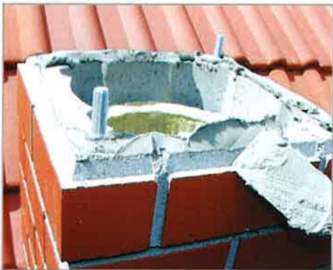
13. Ragasztóhabarcsot hordunk fel az utolsó Schiedel UNI kéményfej elemre. A merevítő-rögzítő csavarokat a két átlós furatba kell elhelyezni!
