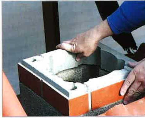
2. Az első Schiedel UNI kéményfej elemet elhelyezzük.
