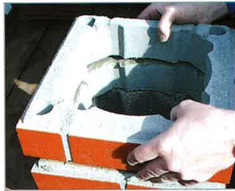
5. A következő Schiedel UNI kéményfej elemet elhelyezzük.
