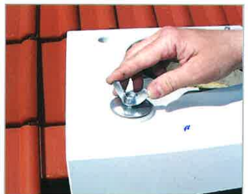
15. Várjunk, amíg a kiöntőhabarcs megszáradul, majd a fedkővet a tömítőalátét elhelyezése után a szárnyasanyákkal rögzítsük.
