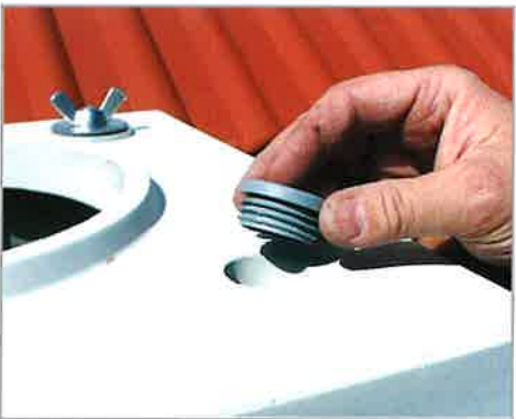
16. Azokat a furatokat, amelyeket nem használtunk, mindig tömítősapkákkal zárjuk le.
