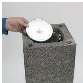
5.2 A védősapkát felhelyezzük a csőre.
