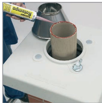
8.7 A csövet ragasszuk a helyére, a vágott vége álljon felfelé. Hordjunk fel a peremére bőségesen ROTEMPO-t.
