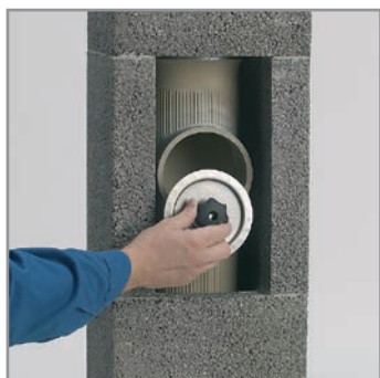
6.1 Helyezzük fel a vizsgálónyílás fedelét.
