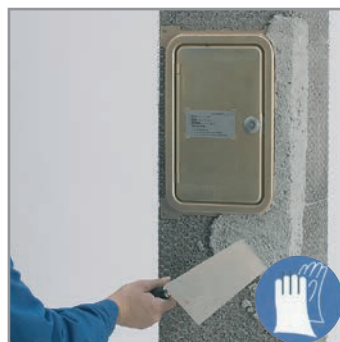
6.3 Vakoljuk be. A repedések elkerülése érdekében használjunk rabitzhálót.
