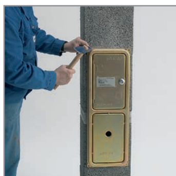
1.9 A lábazati fedőlemezt a nyílás elé rögzítjük.
