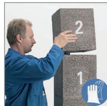
5.4 Felhelyezzük a következő két darab köpenytéglát.
