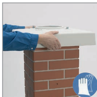
8.3 A fedlapot habarcságyba ültessük.
