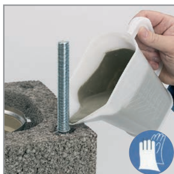
8.2 A sarokfuratokba a megkevert kiöntő habarcsot öntsük bele. Ügyeljünk arra, hogy a kiöntés után is központosan helyezkedjen el lyukban.
