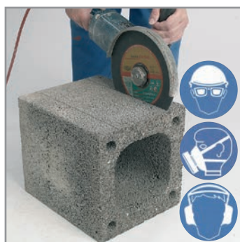
1.5 A vizsgáló ajtó nyílását kivágjuk (kivágási szélesség: 16 cm)
