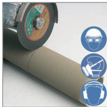
8.6 A profil samottcső tok nélküli végére lesz szükségünk, ennek megfelelően vágjuk méretre.
