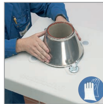
8.8 A torkolati kúpot helyezük rá szintbe állítva. A kitüremkedő masszát a hézaglehúzóval húzzuk le.
