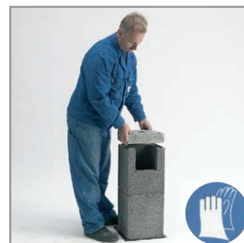
1.4 A beton lábazati lapot habarcságyazatra fektetve beépítjük.
