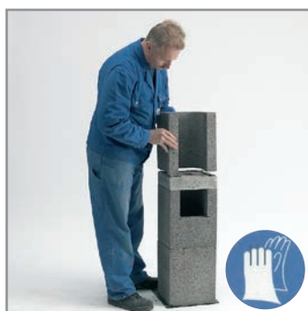
1.6 A kivágott köpenytéglát a lábazati lapra felhordott habarcsra helyezük.
