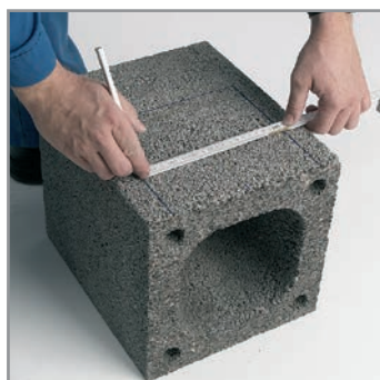
1.2 A kondenzvíz kivezetési nyílását a köpenytéglára berajzoljuk (16 x 16 cm) és a nyílást kivágjuk.
