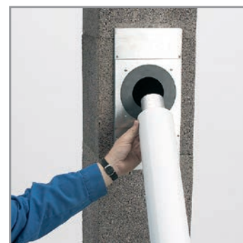
10.4 Az ellenáramú működés esetén koncentrikus füstgáz-levegő cső köthető be.
