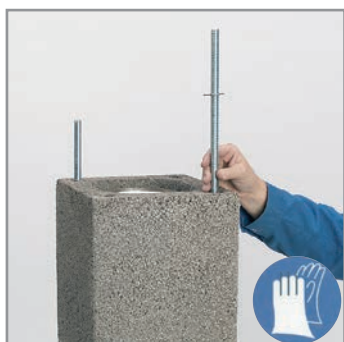
8.1 Csavarjuk össze a két-két rögzítő szárát az egy-egy fedkő rögzítő csavarral, és átlósan helyezzük két sarokfuratba.
