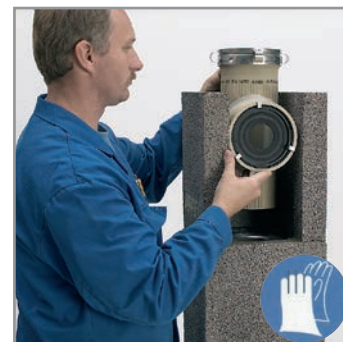
4.8 Tegyük a helyére a füstcső-csatlakozó elemet.
