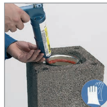
5.8 ROTEMPO-t nyomunk vastagon a profilcső peremére, felhelyezzük a védősapkát. Ezt az építési folyamatot a kéménytorlatig folytatjuk.
