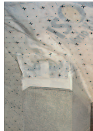
Belső, párazáró fólia csatlakozása a kéményhez
