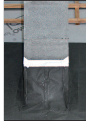
Külső, páraáteresztő fólia csatlakozása a kéményhez
