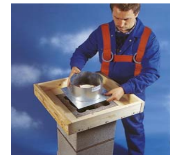
Застосування металевої манжети для заливання покривної плити за місцем.
