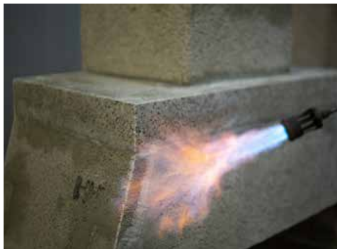
1. Bränn först bort fibrena från ytorna som ska putsas.
