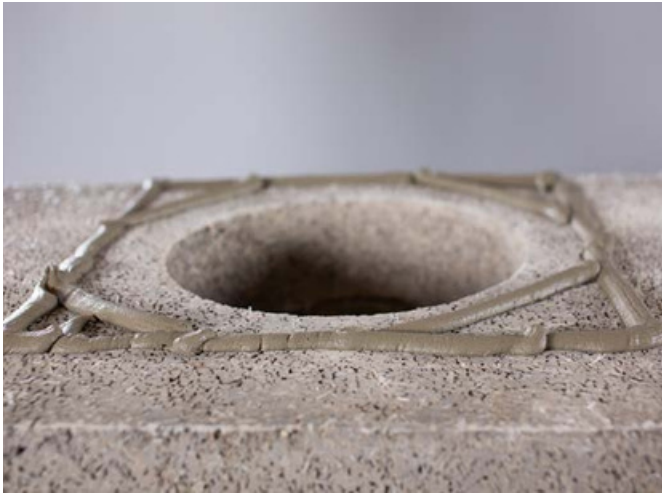
Nanesite lepak na blok dimnjaka, kao na slici.
