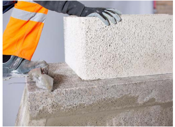
Pritisnite prvi blok dimnjaka na gornju ploču, proverite da li je u ispravnom položaju - iznad rupe na gornjoj ploči.
