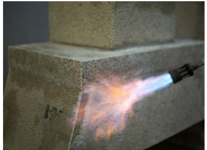
Sagoreti vlakna na spoljnoj površini pre malterisanja.
