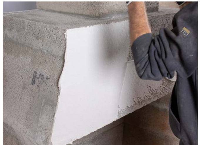
Započnite malterisanje.
