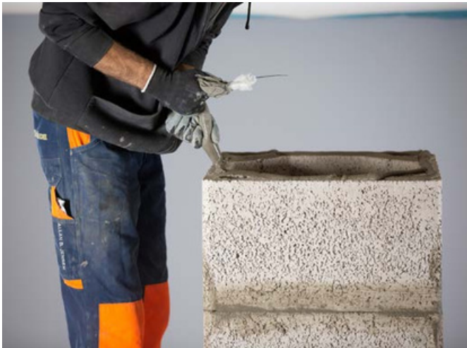
Sazidajte i naredna dva bloka dimnjaka.
