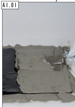
Prípravte zodpovedne maltové lôžko pre pätu a U-modul spolu s vodotesnou izoláciou
