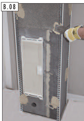
B.08 Pripevnenie omietkových rohovníkov
