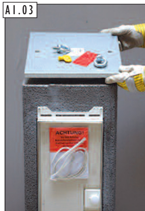
Odstráňte skrutky s okami a vrchný oceľový kryt päty.
