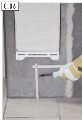
C.06 Na mieste si určite požadovanú stranu pripojenia a rozmery otvoru.
