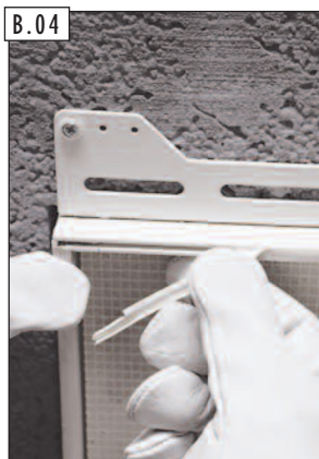
B.04 Detailný pohľad na oblasť závesu dverí s rezom na mieste - ochranné tesnenie v oblasti závesu dverí.
