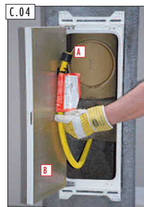
C.04 Ukážka dodávky: pätné dverka (B) a tesnenie (A) naskrutkované na hadici sifónu.
