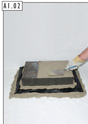
Do maltového lôžka osadíte termoizolačný deliaci prvok (nie je štandardnou dodávkou - na objednávku)
