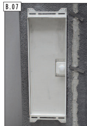
B.07 Hotový pohľad s úplne nainštalovaným ochranným tesnením.
