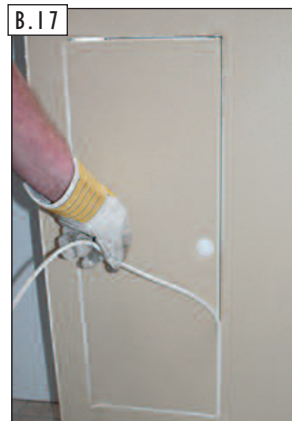
B.17 Ochranné tesnenie vyťahujte vždy opatrne a pomaly.
