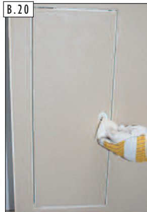
B.20 Ak je to potrebné, špongiou očistite okraj omietky ku krytu.
