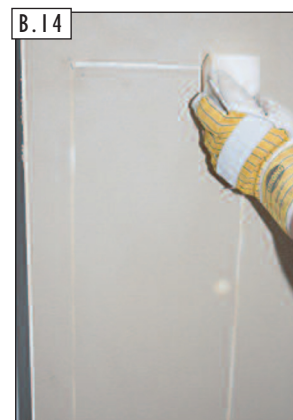
B.14 Ochranné tesnenie prečistite špongiou.
