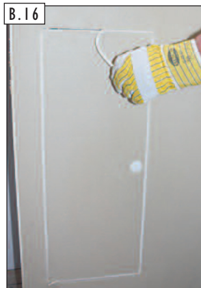
B.16 Ochranné tesnenie sa musí odstrániť hneď, ako začne „tvrdnúť“ finálna omietka.
