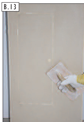
B.13 ... zároveň začistite ochranné tesnenie.
