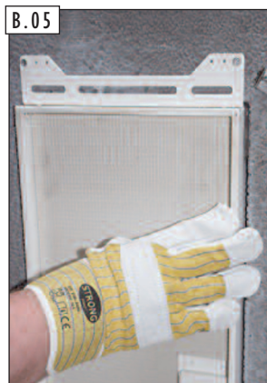
B.05 Pokračujte vo vkladaní ochranného tesnenia a overte si, že sedí „naplocho“.
