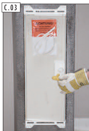
C.03 ... potom odomknite dverka pomocou kľúča dodaného s päťou.
