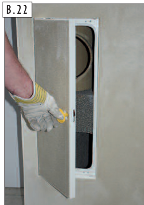
B.22 Funkčná kontrola! Skontrolujte zatváranie dverí pripravených na použitie a odstráňte zvyšky omietky z krídla a rámu dverí.
