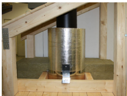
PROTECT BOX inštalovaný do drevenej strešnej konštrukcie
