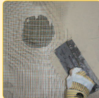
C.3 Nałożyć siatkę o wymiarach co najmniej 10 cm większych niż wymiary kształtki. Siatkę wcisnąć w świeżą zaprawę przy pomocy gładkiej pacy. Powyższe czynności należy powtórzyć, tzn. ponownie wkleić siatkę i nałożyć kolejną warstwę zaprawy.
