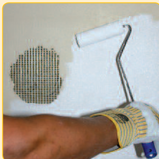
C.5 Nanieść środek gruntujący StoPrep Miral.
