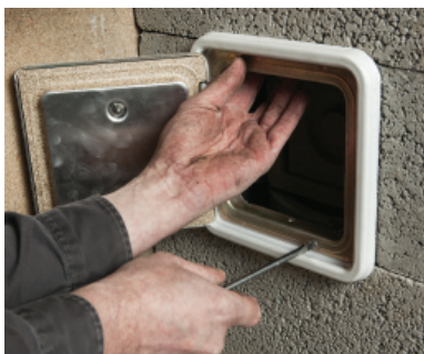
Sotluken skrues fast med medfølgende skruer og festebeslag.
