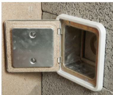
Pass på at den innvendige rammen på sotluken skyves inn mot rammen på sotluckerøret. Deretter monteres medfølgende dørstein. Påfør fugekitt mellom rammene for optimal tetthet.
