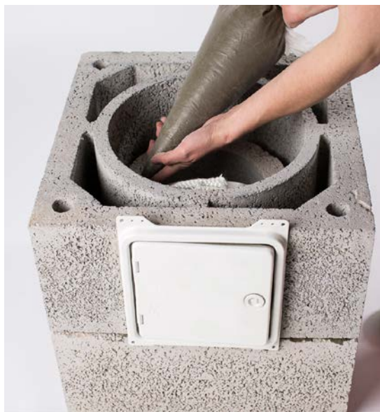
Snoren plasseres rundt stussen på sotluken og det påføres pipemørtel på sotluckerøret.
