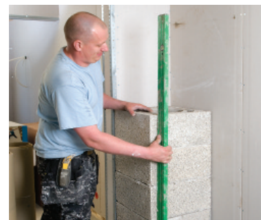
Skorsteinen loddes opp med vater.
