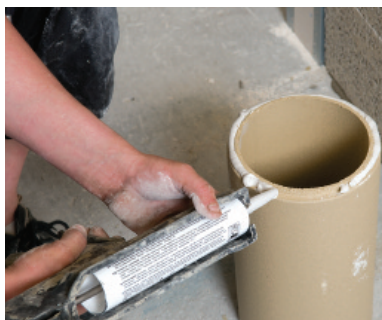
Foringsrøret påføres fugekitt på nedre fals før det monteres. Husk og fjerne overskytende fugekitt innvendig.
