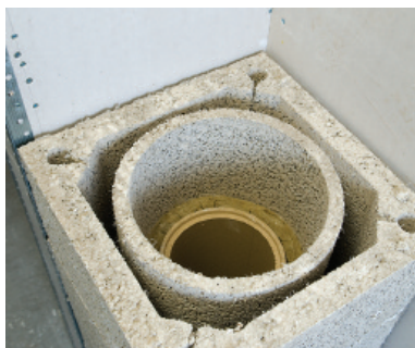
Ytterelement, isolasjon og foringsrør monteres.
