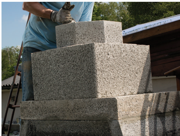
„Isokern DM“ elementų montavimas
