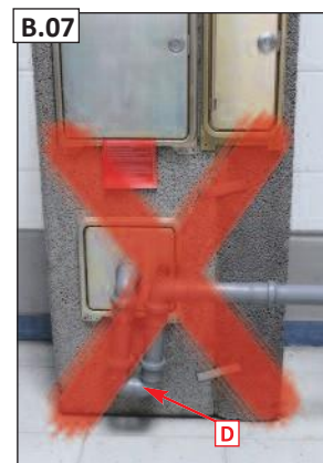
Kondensatui į grindinį lataką nuvesti kamino išorėje naudojami DN 40 karščiui atsparūs vamzdžiai išplatėjančiu galu.
