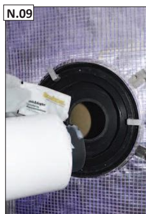
Įcentruotą jungiamąjį vamzdį patepkite lubrikantu ir sumontuokite.
