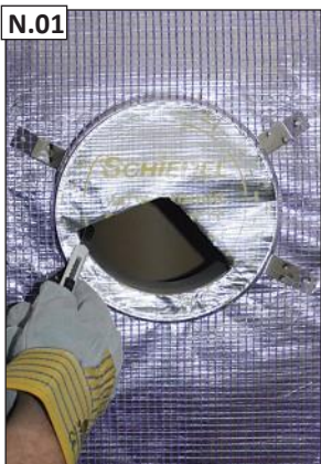
Ties esamomis žymomis peiliuku išpjaukite angą specialioje aliumininio audinio plėvelėje.
