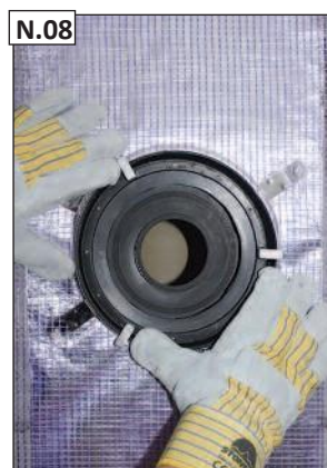
Naudodami lubrikantą, į potinkinį žiedą įstatykite išorinį kišamąjį adapterį.
