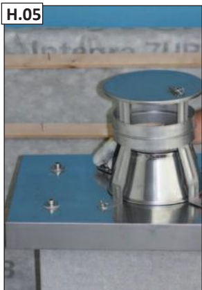
H.05 Ant tvirtinimo kaiščių uždėkite poveržles ir ranka priveržkite nerūdijančiojo plieno sparnuotąsias varžles.
