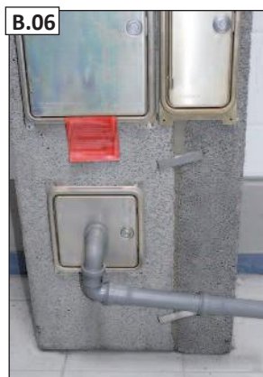
Kondensatui į grindinį lataką nuvesti kamino išorėje naudojami DN 40 karščiui atsparūs vamzdžiai išplatėjančiu galu.
