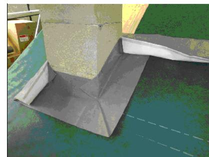
Ripetete l'operazione con il terzo lembo. Incollate i sormonti fra loro col nastro adesivo. Posizionate infine il **lembo superiore** che deve sempre arrivare a sormontare il lato superiore del terzo lembo.
