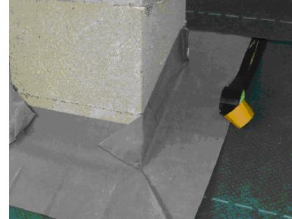
Effettuate un taglio sull'angolo del lembo superiore sufficiente a permettervi di piegarlo e di chiudere il tutto sormontando. Sigillate infine anche i bordi esterni della scossalina fissandoli col nastro adesivo alla copertura dell'estradosso
