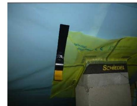
Sormontate gli angoli a filo della camicia e incollate col nastro. Sigillate infine anche i bordi esterni della scossalina fissandoli col nastro al rivestimento dell'intradosso.
