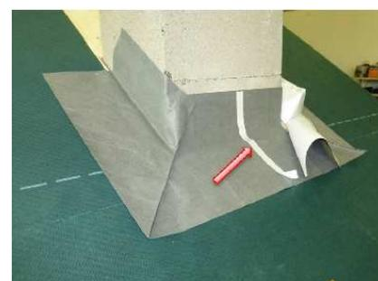
Seguendo la sequenza sovraindicata, posizionate il primo lembo e fissatelo a filo della camicia. Posizionate il secondo, fissatelo, tagliate il sormonto in eccesso e sigillate con l'apposito nastro adesivo.
