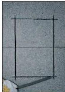
Utilizzate l'apposita lama per tagliare l'isolamento termico integrato in schiuma cementizia
