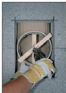
Applicate un sostegno interno di fissaggio
