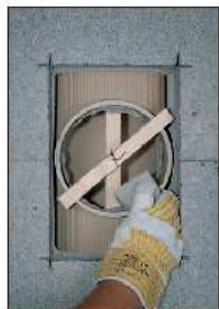
Pulite accuratamente le fughe, lasciar asciugare il sigillante (ca 48 h)
