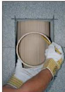
Usate lo stacco dell'ispezione come sagoma e segnate sul condotto interno in ceramico refrattario la sezione da tagliare
