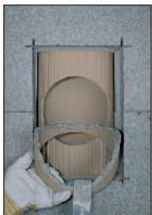
Applicate il sigillante per refrattario sul bordino dello stacco e pulire le fughe
