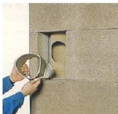
Applicare il sigillante per refrattario sul bordino dello stacco e pulire le fughe
