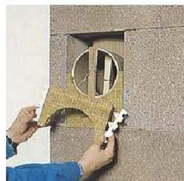
Inserire il pannello frontale isolante in lana di roccia per chiudere la derivazione
