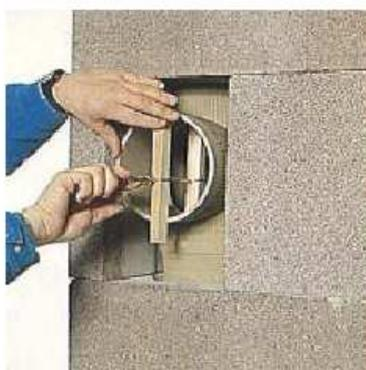
Applicare un sostegno interno di fissaggio, lasciar asciugare il sigillante
