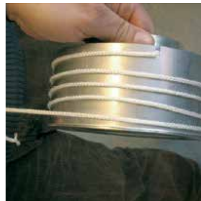
A tömítő zsinórt a csatlakozó hüvelyre tekerjük.
