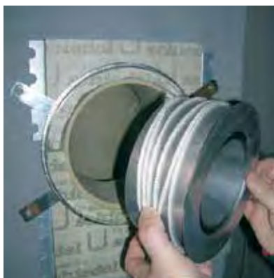
A csatlakozó hüvelyt a kerámia füstcső-csatlakozóba nyomjuk. (A zsinór rátekerésének irányát követő csavaró mozdulattal.)
