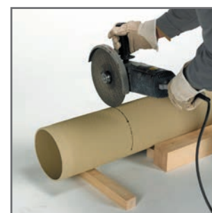
4.12 Az utolsó kerámicsőből annak beragasztása előtt vágjuk le ezt a méretű darabot. FIGYELEM! A tokos csővég esik le. A sima felületűt kell beragasztani. Id. 4.13-4.15. képek.
