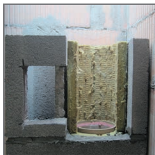
5.10 Helyezzük bele a szigetelő lapokat, és a hátsó szellőzési csatorna hátsó él mentén vágjuk vissza úgy, hogy a köpenytéglán kivágott nyílást ne takarja be.
