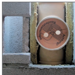
5.11 Ragasszuk be a füstcső-csatlakozó idomot.
