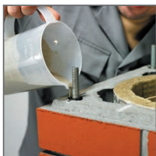
4.6 A furatokban elhelyezett csavarokat öntsük ki a készlethez szállított kiöntő habarccsal.
