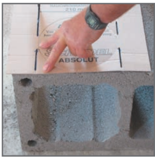
5.1 A köpenytéglán rajzoljuk meg, majd vágjuk ki a füstcső-csatlakozó elem nyílását.
