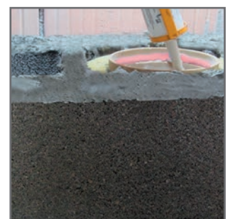
5.8 A köpenytéglára a habarcssablon segítségével hordjunk fel habarcsot, a cső peremére pedig hézagtomítót.
