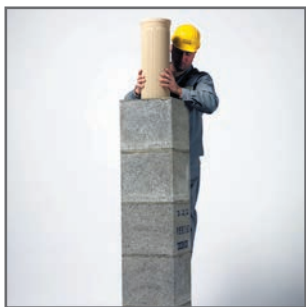
4.1 Négy köpenytégla egymásra építése és a szigetelő lapok behelyezése után az 1,33 m-es kerámiacsövet ragasszuk a helyére. A kinyomódott hézagkittet a hézaglehúzóval húzzuk ki. Az építési folyamatot a következő csatlakozóig vagy a torkolatig ismételljük.
