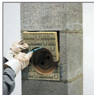
3.7 Vágjuk méretre az előlapot és a sarokvasak felhelyezésével illesszük a helyére.
