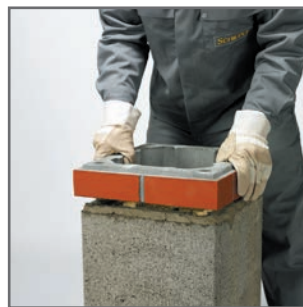
4.3 UNI kéményfejes fejkialakítás esetén helyezzük rá az első kéményfej elemet. Folytassuk a betonelemek és a kémény építését a torkolatig.
