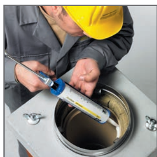
4.13 Tisztítsuk meg és nedveítsük a cső peremét, hordjunk fel rá samottragasztót.
