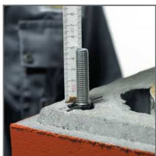
4.5 A rögzítő csavar max. 5 cm-t állhat ki.
