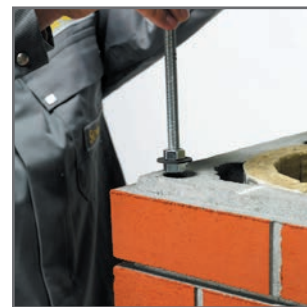
4.4 Két rögzítő csavart helyezünk be két átlósan elhelyezkedő furatba, ügyeljünk rá, hogy a gumitömítést a csavarszár alsó végén megfelelően rögzítsük.
