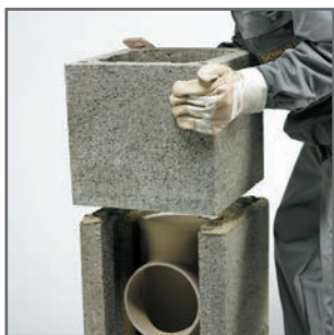
3.1 A következő köpenytéglát helyezzük a habarcságyra...
