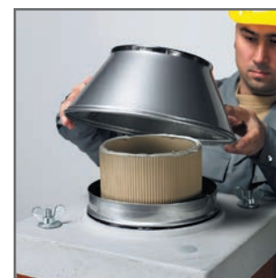
4.16 A fedlapra helyezve illesszük a helyére a torkolati kúpot.
