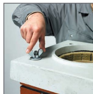
4.8 A fedkövet a tömítő-alátét elhelyezése után, rögzítsük a szárnyasanyákkal. A két másik furatot tömítő sapkával zárjuk le.
