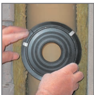
5.17 Vegyük ki a füstcső-csatlakozóból a papírkartont és illesszük a helyére a steckadaptert.
