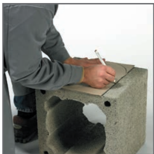
3.5 A köpenytégla oldalán jelöljük ki a füstcső-csatlakozó nyílás nagyságát (a 2-es táblázat szerint), majd sarokcsiszolóval vágjuk ki a nyílást.
