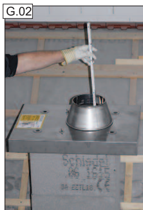
A fém fedlapot és a torkolati kúpot a mérés miatt csak lazán felhelyezzük és a torkolati kúp tetejéig lemérjük a hiányzó csőmagasságot.
