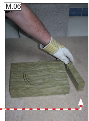
M.05 A fűrészlap segítségével vágjuk méretre az előlapot. A levágott darabot tegyük át a másik oldalra (ld. szaggatott nyíllal jelölve). A belső maggyűrűk és a mag maradjanak az előlapban merevítésként. FIGYELJEN az egyenes vágásra! MEGJEGYZÉS! Javasoljuk, hogy HSS fogazású bimetal fűrészlapot használjon a hőszigetelő előlap vágásához.
