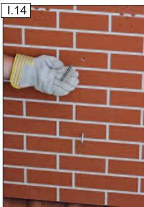
Tekerjük be a csavarokat az oldalsó furatokba.
