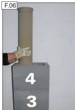
Az így felépített négy köpenytéglába helyezzük bele az 1,33 méter hosszú profilcsövet.
