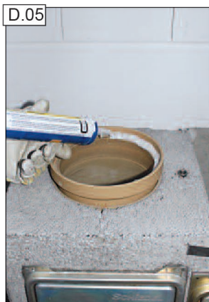
Hordjunk fel bőségesen tubusos hézagkitetett az adaptergyűrűre.
