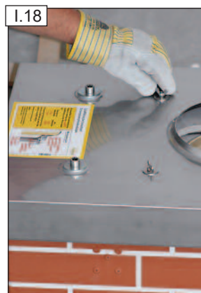
Az esővédő sapka rögzítőit is szereljük be.
