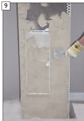
9 Az alapvakolat felhordása a rejtett ajtós kéménylábra és a rejtett kéményajtóra.
