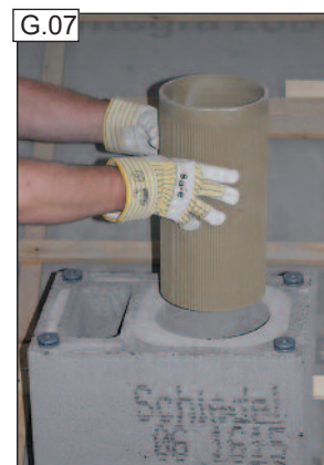
Helyezzük fel ezt a méretre vágott, utolsó profilcsövet.
