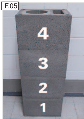
Négy köpenytéglát építsünk a bemutatott, habarcsos ragasztással egymásra.
