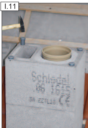
I.11 A dűbeleket üssük be a sarokfuratokba.
