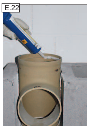
E.22 A tubusos hézagkittét bőségesen hordjuk fel az idom felső tokrészére.
