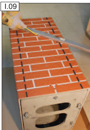
A szükséges dőlésszöget minden oldalon rajzoljuk fel a kéményfejre.
