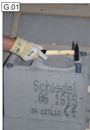
A dübeleket a sarokfuratokba beütjük.
