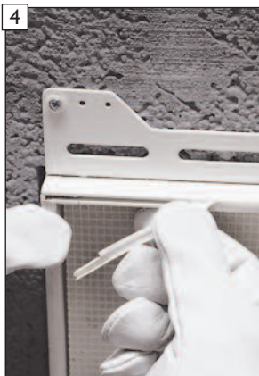
4 A helyszínen méretre vágott védőtömítés behelyezése a zsanéroknál. (Ez a tömítés védi a vakolatfelhordás közben az ajtót.)
