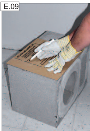
Tegyük a sablont a köpenytéglára és rajzoljuk fel a kivágási méretet.
