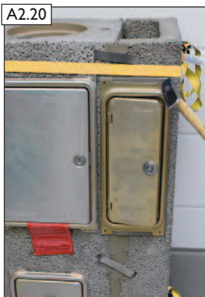
Az előkészített vizsgálóajtót szegeljük fel a levegőmodulra.
