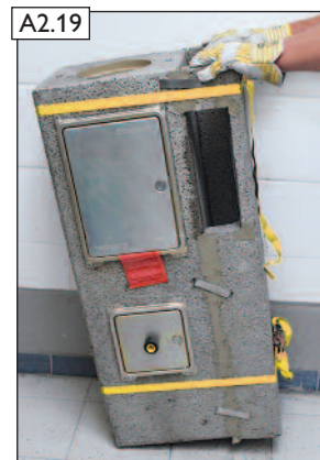
A2.19 A kész kéménylábat így már be lehet helyezni az előkészített habarcságyba. FONTOS! A pántolószalagot 48 órán belül ne oldjuk ki.
