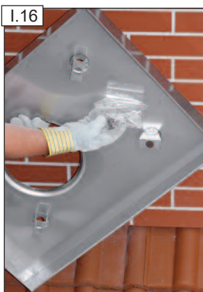
Az esővédő sapka rögzítését vegyük le a fém fedlapról.
