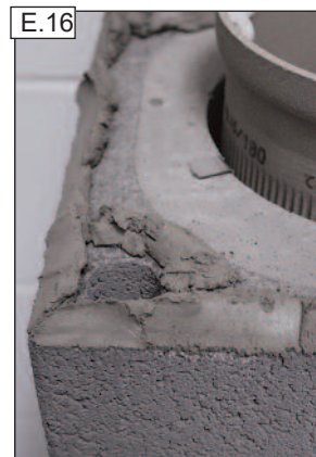
FIGYELEM! Ügyeljünk a habarcs folytonos felhordására a peremrészeknél is!
