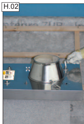
A fémfedlap két BKNY csavarját a szilikontömítéssel és alátétekkel a kitorcolási oldalon kicsavarozzuk.
