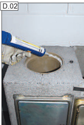
A tubusos hézagkitetett bőségesen hordjuk fel a cső peremére.
