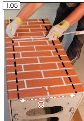
A lemért hosszúságot C a kéményfejre központosítva rajzoljuk fel a köpenytégla szélességében.
