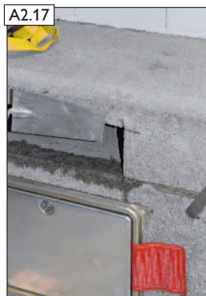
A2.17 A levegőkürtös modulon lévő túlvágásokat is töltjük ki.
