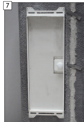
7 A teljesen behelyezett védőtömítés készre szerelve.
