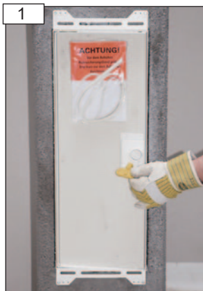
1 Nyissuk ki a kész kéménylábat, a képek alapján: 15. oldal B1.01-től a B1.04-ig.
