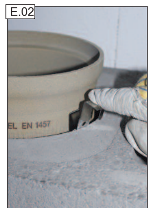
Nyomjuk be a távolságtartókat (3 db) egyenlően elosztva a habbeton szigetelésbe.
