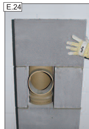
E.24 Helyezzük fel a következő köpenytemplát.
