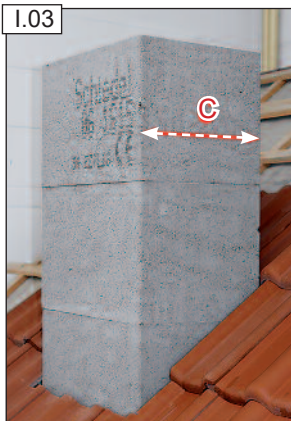
Mérjük meg a kémény szélességét C
