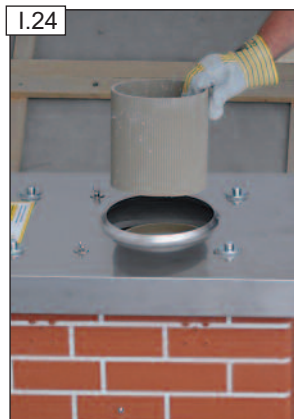
Helyezzük be a profilcsődarabot.
