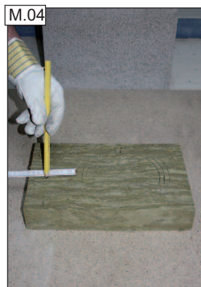
M.04 Jelöljük rá a felső vagy az alsó nyílásméretet az előlap hosszabbik oldalára.
