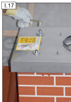
A rögzítőcsavarokat a leírásnak megfelelően szereljük be.
