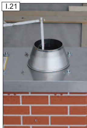
... és a torkolati kúp tetejéig mérjük le a hiányzó csőmagasságot.
