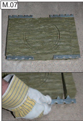
Illesszük a sarokvasakat az előlapba. Kapcsoljuk össze a elvágott előlapokat a sarokvasakkal.
