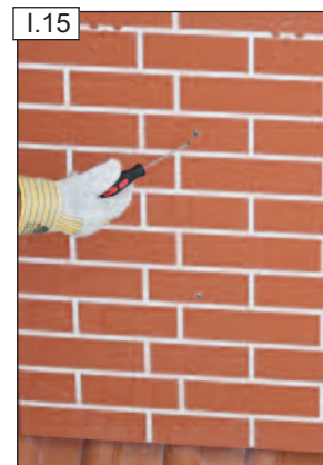
Húzzuk meg a csavarokat annyira, hogy a kéményfej függőleges helyzetbe kerüljön.
