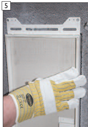
5 Helyezzük be végig a védőtömítést, figyeljünk, hogy síkba nyomjuk be.
