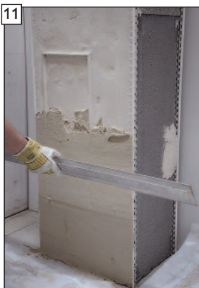
11 A fedővakolat felhordása a helyszínen.
