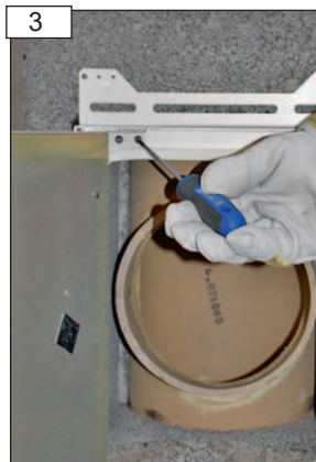
3 Csavarozzuk ki a felső ajtózsánér csavart...
