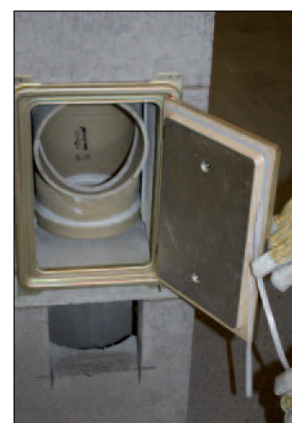
Speciális belső tömítő az ajtólap belső oldalára kerül felragasztásra
