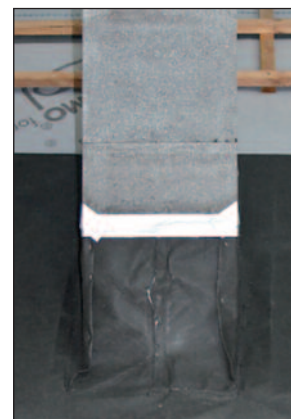
Külső, páraáteresztő fólia csatlakozása a kéményhez
