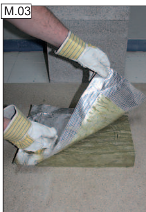
M.03 Óvatosan húzzuk le az alumínium fóliát az előlapról.
