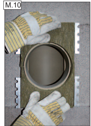
A méretre igazított előlapot tegyük a helyére...
