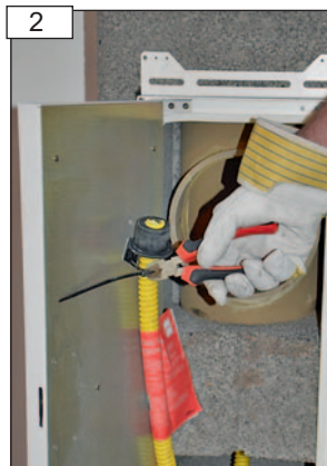
2 A szifonról a kábel rögzítőt távolítsuk el.
