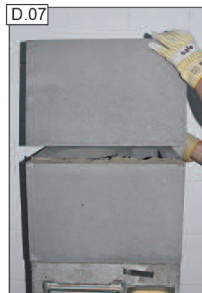
A további köpenytéglákat helyezzük egymásra, (természetesen mindegyiknél a felhordott ragasztóhabarcsba,) egészen a füstcső csatlakozókialakítás magasságáig.
