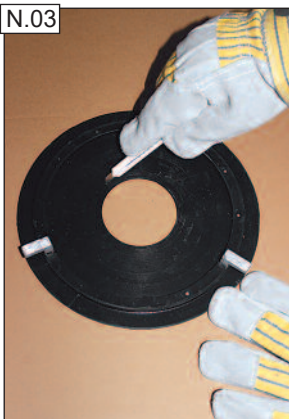
A Steckadapteren a kazánbekötő csőhöz megfelelő méretű belső nyílás kialakítása is szükséges helyszíni csatlakozáshoz.
