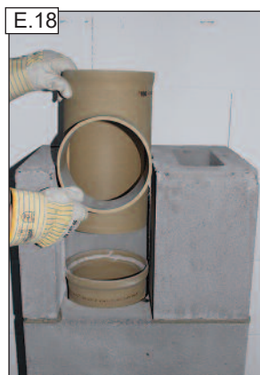
E.18 Tegyük helyére a füstcső T-idomot. (RA) \varnothing 20 cm átmérőig az idom hossza 33 cm, \varnothing 25 cm fölött a T-idom hossza 66 cm.
