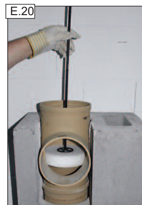
E.20 A kinyomódott ragasztót a hézaglehúzóval húzzuk ki.
