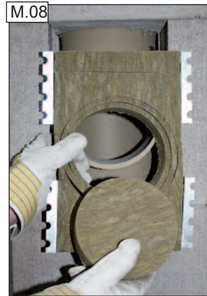
A belső előlap darabot vegyük ki.
