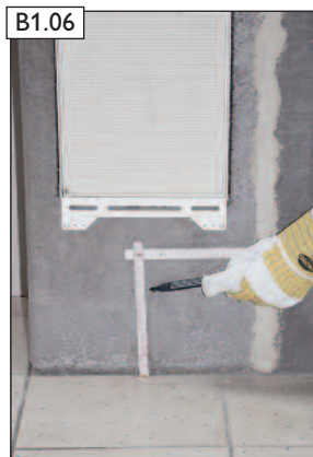
B1.06 Jelöljük meg a megfelelő oldalon és magasságban a szükséges nyílás helyét.
