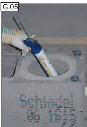
Tubusos hézagkittet hordjuk fel bőségesen a tokrésze.
