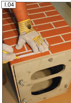
A lemért hosszúságot C a kéményfejre központosítva rajzoljuk fel a köpenytégla szélességében.
