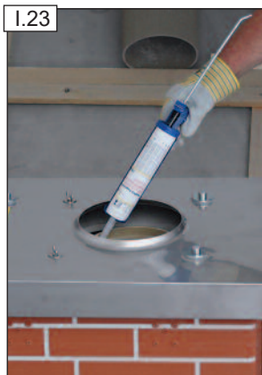
Alaposan kenjük be ragasztóval.
