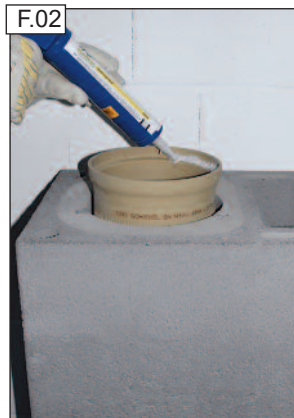
Hordjunk fel bőségesen a csőperemre tubusos hézagkittet.
