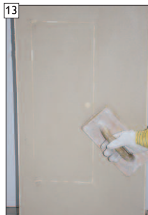
13 .... és közben a védőtömítést szintre hozva kidörzsöljük.
