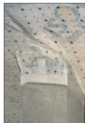
Belső, párazáró fólia csatlakozása a kéményhez
