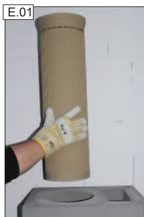
Helyezzük be a 66 cm hosszú profilsövet (a füstcső-csatlakozó csomagban található).
