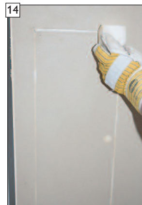
14 Szivaccsal is dolgozzuk ki, hogy jól látható legyen.
