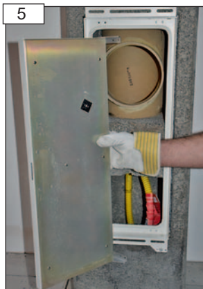
5 Az ajtólapot óvatosan vegyük le. FIGYELEM! A belső tömítés ne sérüljön meg!
