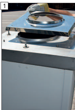
Helyezzük fel az adaptergyűrűt a rögzítő csapszegekre.
