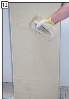
12 A fedővakolatot az előírásoknak megfelelően elsímítjük...
