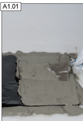
A1.01 A kész kéménylábhoz és a szellőző modulhoz M5 Ila habarcságot készítünk. (habarcs MSZ EN 998-2 szerint), vízzáró réteget felhelyezzük, a habarcsot felhordjuk.
