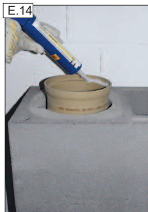
A tubusos hézagkittet bőségesen hordjuk fel az adaptergyűrűre.
