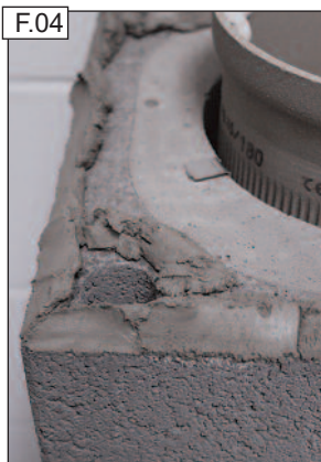
FIGYELEM! Ügyeljünk a habarcs folytonosságára a sarokfurat melletti peremrészekben. A szigetelésre ne kerüljön habarcs!
