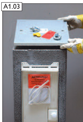
A1.03 Eltávolítjuk a csavarokat és a szállítási fedőlemezt.
