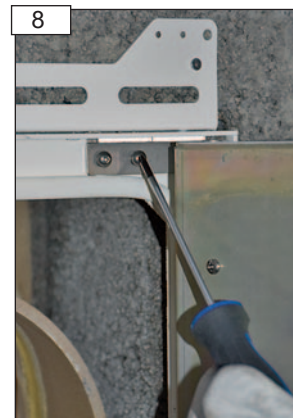
8 Az ajtólapot így az ellenkező oldalon már fel is tudjuk szerelni. FIGYELEM! A tömítésre vigyázzunk, nehogy megsérüljön!
