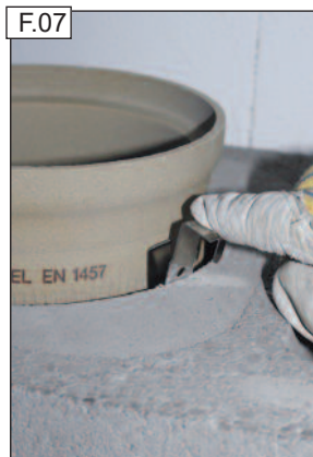
A távolságtartókat (3 db) körben elosztva a szűrjük a habbeton szigetelésbe.
