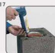
4. STANDARDNI POSTUPAK MONTAŽE Schiedel ROTEMPO nanijeti u debelom sloju na utor proilne cijevi.
