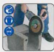
Otvor za priključak izrezati pomoću kutne brusilice.
