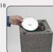
Zaštitu fuge položiti na proilnu cijev.
