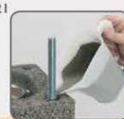
5. KONUSNI ZAVRŠETA Armaturu ili vijak za učvršćivanje vanje završne ploče u kanalima zaliti tekućim betonom. Obratiti pažnju na jednake razmake.
