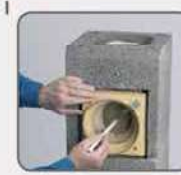
Profilnu cijev umetnuti u plašt, te na njoj označiti položaj priključka.
