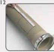
Na profilnoj cijevi označiti otvor dimenzije 11.5 x 11.5 cm
