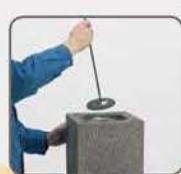
Fugu profilne cijevi zagladiti i očistiti alatom za čišćenje.
