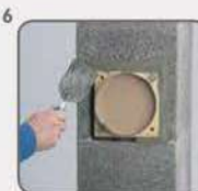
Umetnuti i zalijepiti vanjski dio priključka u plašt (umetnuti zaštitu).
