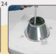
Postaviti konusni završetak i izmjeriti potrebnu duljinu završne cijevi.
