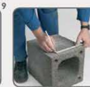
3. OTVOR ZA MULTI PRIKLJUČAK Na plaštu označiti otvor dimenzije 21 x 21 cm.
