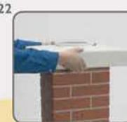
Završnu ploču, postaviti na rešetku za dovod zraka i zatim na pripremljeno ljepilo.
