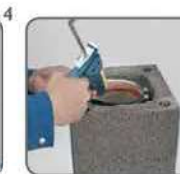
Schiedel ROTEMPO u debljem sloju nanijeti na utor profilne cijevi.
