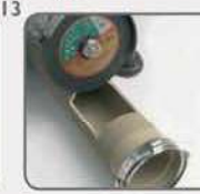
Otvor na cijevi izrezati pomoću kutne brusilice.
