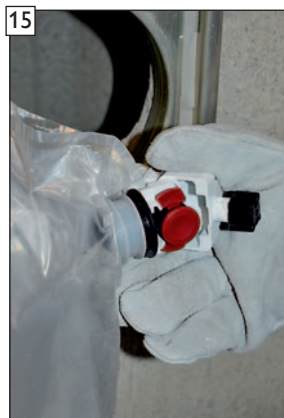
Verriegelung des BIB-Connectors öffnen und BIB-Anschlusshahn mit dem Kondensatauffangbeutel aus dem Kuppungsteil herausziehen.
