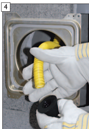
4 Adapter für HT-Rohrverbindung DN40 vom Siphonschlauch abschrauben.
