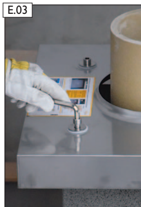
3. Edelstahl-Inbusschrauben M12 handfest anziehen .
