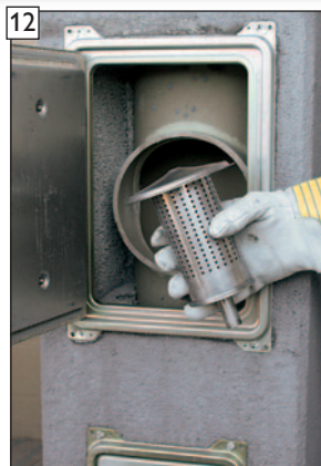
TIPP! Wir empfehlen den patentierten Kondensatfilter (Art.-Nr.: 157327) zum sicheren Schutz vor Verstopfungen in den Ablaufleitungen!
