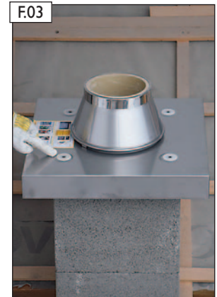
Silikondichtungen auf Zuluftkopfplatte-Edelstahl auflegen. Regenhaube „EAGLE“ aufsetzen.
