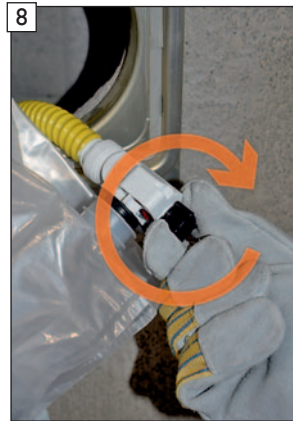
Verriegelung des BIB-Connectors im Uhrzeigersinn schließen.
