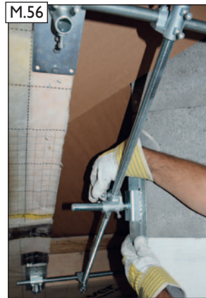
M.56 Spannwinkel ausrichten und vorfixieren.
