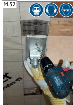
M.52 Sparrenhalter anhalten und Nagellöcher gemäß dem Nagelbild (siehe oben) vorbohren. ACHTUNG! Beachten Sie bitte die Hinweise zum Arbeitsschutz auf Seite 2!
