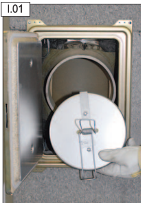
I.01 Revisionsverschluss „F“ für Festbrennstoffbelegung einsetzen.
