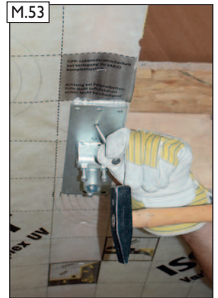
M.53 Sparrenhalter mit Kammnägeln (E) ausnageln.
