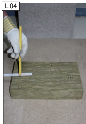
Wahlweise oberes oder unteres Öffnungsmaß auf der längeren Seite übertragen.
