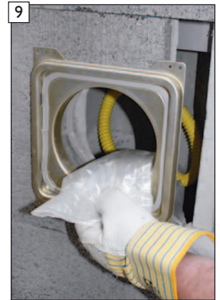
Siphonschlauch und Kondensatauffangbeutel in Schornsteinfuß einschieben.
