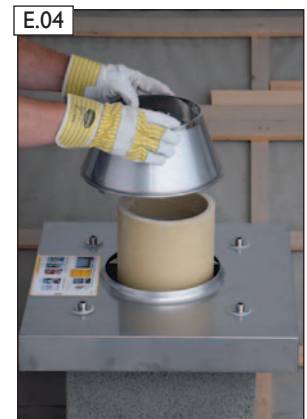
Konus aufstecken. WICHTIG! Oberkante Konus muss auf dem Keramikrohr aufliegen!
