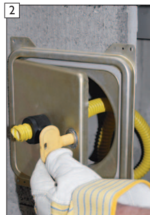
2 Kondensatblendentürblatt öffnen.
