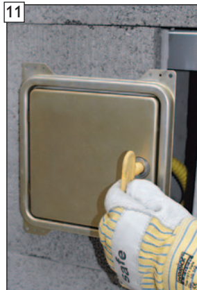
Kondensatblendentürblatt wieder verschließen.
