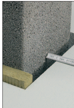
Montageausparung allseitig 3 cm größer als Mantelsteinmaß.
