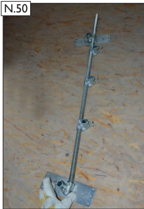
Zweiten Schornsteinhalter vorbereiten. Spannkreuze und Sparrenhalter lose auf die Gewindestange auf-fädeln.
