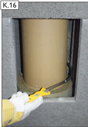
Der Dämmstoff muss vollständig bis zu den hinteren Zuluftkanälen entfernt sein.
