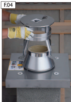
Regenhaube „EAGLE“ auf die Silikondichtungen auf-setzen.
