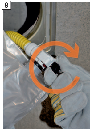
8 Verriegelung des BIB-Connectors im Uhrzeigersinn schließen.
