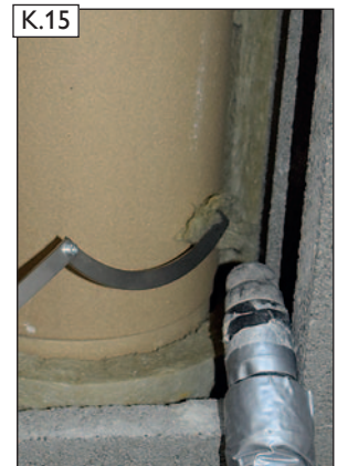
Kleine Dämmstoffreste immer sofort mit dem Staubsauger aufnehmen.
