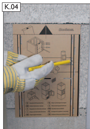
Mit der Schnittschablone Öffnungsbreite für die Mantelsteinscheibe anzeichnen.
