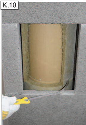
Das 1/4-Kreis Gelenk-Dämmstoffmesser ansetzen.
