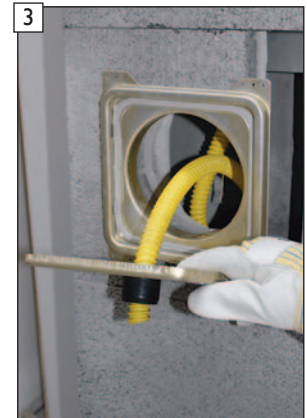
3 BlowerDoor Kondensatblendentürblatt abnehmen und Adapter für HT-Rohrverbindung DN40 mit Siphonschlauch herausziehen.
