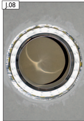
J.08 Fertigansicht des eingebauten Anschlussfutters mit E-Glas Flachdichtung.
