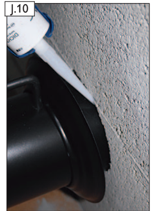
J.10 Die Zuluftleitung an der Öffnungsbohrung im Schornstein muss bauseitig abgedichtet werden.
