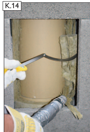
Seitlichen Dämmstoff mit dem 1/4-Kreis Dämmstoffschaber entfernen.
