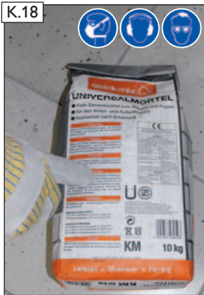
Mauermörtel gem. den Verarbeitungshinweisen auf der Verpackung anmischen.
