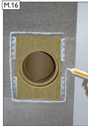
BlowerDoor A270 Dichtheitskleber ( vor Frost schützen ) auftragen - 8 mm Raupe.
