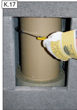
Kontrollieren Sie mit dem 1/4-Kreis Dämmstoffschaber ob die beiden hinteren Zuluftkanäle frei von Dämmstoff sind. Die Benutzung einer Taschenlampe, zum Ausleuchten der Kanäle, hilft Ihnen dabei.
