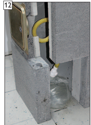
12 Fertigansicht am Beispiel: Ausführung mit geschlossenem Kondensatblendentürblatt und angeschlossenem Kondensatauffangbeutel.
