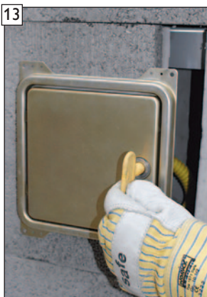
13 BlowerDoor Kondensatblendentürblatt abnehmen.
