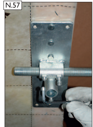
Gewindestange fixieren. Dazu die Abreißschrauben an beiden Sparrenhaltern mit Inbusschlüssel (F) anziehen bis der Schraubkopf an der Sollbruchstelle abreißt. Erst danach Spannwinkel fixieren (siehe Bild N.58).
