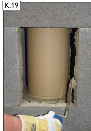
Umlaufenden Mörtelauftrag vornehmen.
