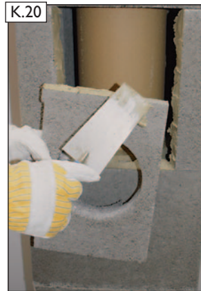
Mantelsteinscheibe umlaufend mit Mörtelraupe versehen.
