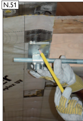
Aufgefädelt Einzelteile zum einrichten anhalten. Einbauposition für den Sparrenhalter markieren. Danach Einzelteile aus-fädeln.
