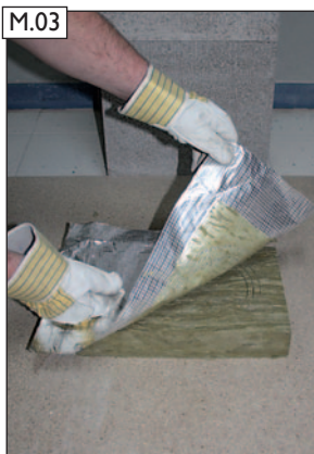
Für den Zuschnitt, die Spezial-Alugewebefolie vorsichtig von der BDF lösen.
