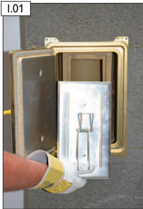
Vorsatzschale einsetzen.
