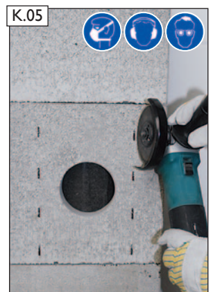
Öffnungsschnitt vornehmen und ... ACHTUNG! Beachten Sie die Hinweise zum Arbeitsschutz auf Seite 2!
