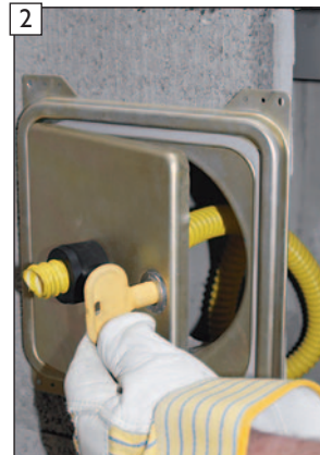
2 Kondensatblendentürblatt öffnen.
