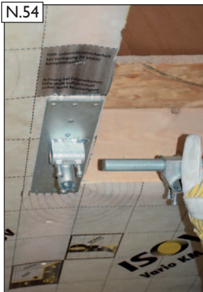
Gewindestange und 45° Spannwinkel wieder ein-fädeln und ausrichten.
