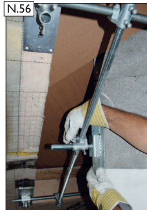
Spannwinkel ausrichten und vorfixieren.
