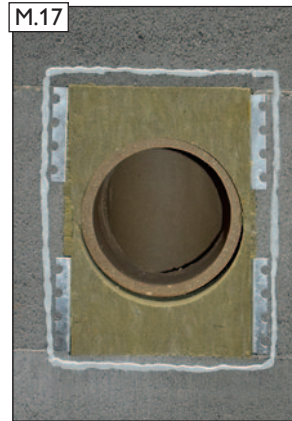
Ansicht des umlaufend vollständig geschlossenen Kleberauftrages.
