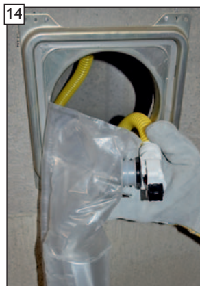
14 Kondensatauffangbeutel vorsichtig herausziehen.
