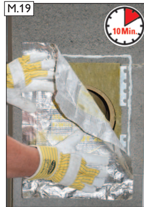
Spezial-Alugewebefolie innerhalb von 10 Minuten ausgerichtet ansetzen und ...
