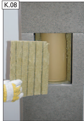
Dämmstoffsicht vollständig entfernen.
