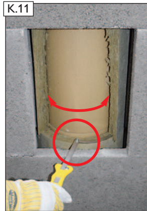
Mit entsprechender Gelenkdrehung vollständig seitlich um das Innenrohr herumschneiden.
