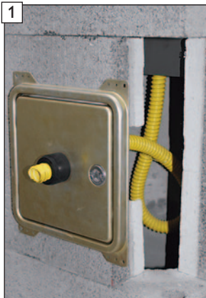
1 Lieferzustand ab Werk: Siphonschlauch und Adapter für HT-Rohrverbindung DN40 sind in der BlowerDoor Kondensatblendentür eingesteckt.
