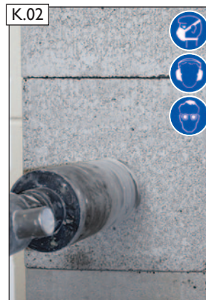
Bauseitig erforderliche Öffnungsbohrung herstellen. ACHTUNG! Beachten Sie die Hinweise zum Arbeitsschutz auf Seite 2!
