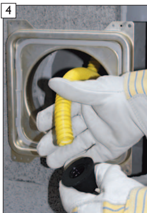
4 Adapter für HT-Rohrverbindung DN40 vom Siphonschlauch abschrauben.
