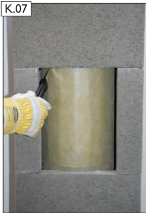
Vordere erreichbare Dämmstoffsicht mit Cuttermesser freischneiden.
