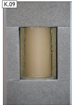
Fertigansicht der entfernten vorderen Dämmstoffsicht.
