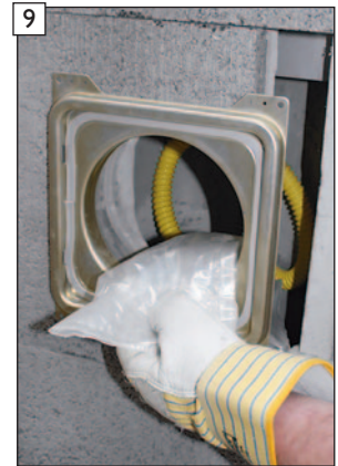
9 Siphonschlauch und Kondensatauffangbeutel in Schornsteinfuß einschieben.
