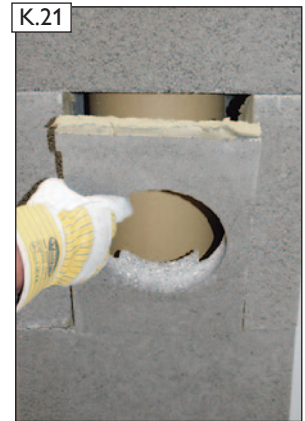
Mantelsteinscheibe in die Öffnung einsetzen. ACHTUNG! Auf richtige Einbaurichtung achten!
