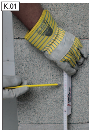
Bauseitig erforderliche Anschlussrichtung und Anschlusshöhe am Mantelstein einzeichnen.
