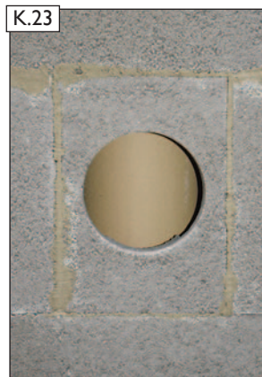
Ansicht der fertig eingemörtelten Mantelsteinscheibe.
