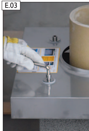
E.03 3. Edelstahl-Inbusschrauben M12 handfest anziehen .
