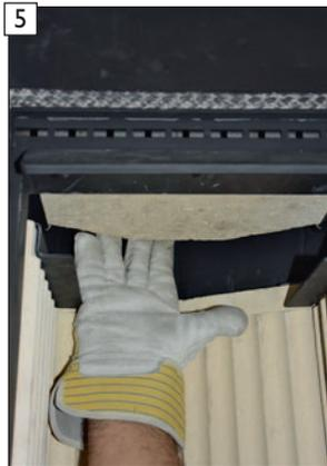
5 Obere Umlenkplatte soweit zurückschieben bis diese in der Anschlag Nase des Kombihaltewinkels einrastet.
