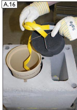
A.16 Inneres Zugseilende mit der Unterseite des oberen Schutzschwamms Abgas (3) verknoten.
