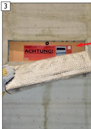
3 Konvektionsluftgitter aus der Montageöffnung entfernen.
