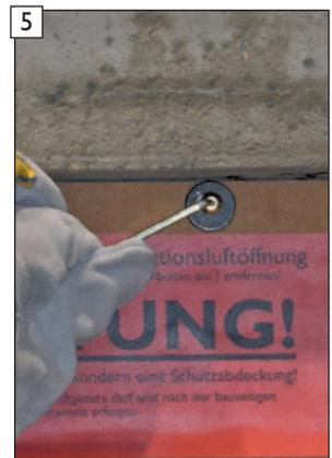
5 Inbus-Sicherungsschraube für Konvektionsluftgitter heraus-schrauben.
