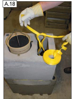
A.18 Äußeres Zugseilende mit dem unteren Schutzschwamm Zuluft (2) sicher verknoten.
