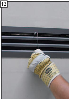
Inbus-Sicherungsschraube durch die Aufnahme des Konvektionsluftgitters stecken und am Haltewinkel festschrauben.
