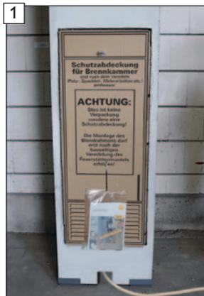
Ansicht der werkseitigen Schutzabdeckung nach Beendigung der bauseitigen Veredelungsarbeiten am Feuerstättenmantel.
