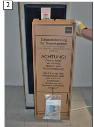
2 Werkseitige Schutzabdeckung entfernen.
