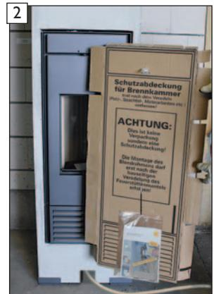
Werkseitige Schutzabdeckung entfernen.
