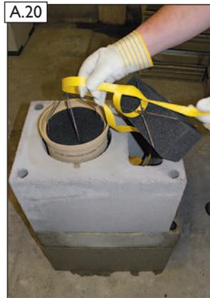
A.20 Inneres Zugseilende mit der Unterseite des oberen Schutzschwamms Zuluft (4) sicher verknoten und bündig bis zur Mantelsteinoberkante einstecken.
