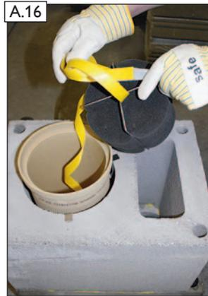
A.16 Inneres Zugseilende mit der Unterseite des oberen Schutzschwamms Abgas (3) verknotten.
