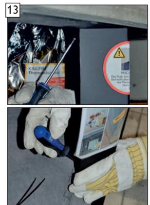
... kann dieser durch Lösen und Nachstellen der „Längsaussteifung“ oben und unten am Montagerahmen wieder problemlos „entspannt“ werden.
