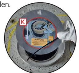
L - Die werkseitige Schutzabdeckung der Konvektionsluftöffnung erst nach Ende der bauseitigen Putz- und Malerarbeiten entfernen.
