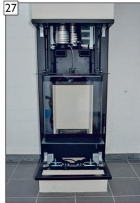
Montagezugang am Gleitlager wieder schließen. Montage erfolgt in umgekehrter Reihenfolge gem. den Arbeitsschritten 9 bis 12 auf Seite 40.
