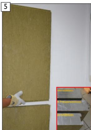
5 Doppelfederplatte in die Nutplatte einstecken und ...
