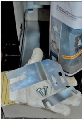
... Halteklammer und Kabelklemme entfernen.
