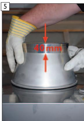
Konus bis ca. 2-3 mm auf Zuluftkopfplatte aufschieben.
