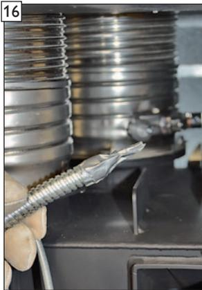
16 Druckmessschlauch und Temperaturfühler mit Klebeband gegen Beschädigungen und Herausrutschen aus dem Metallschlauch sichern.
