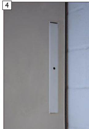
Ansicht der Schutzklammer für den werkseitig eingebauten Montagekasten gegen Verschmutzung bei bauseitiger Veredelung (Putzen/Spachteln/Malerarbeiten)
