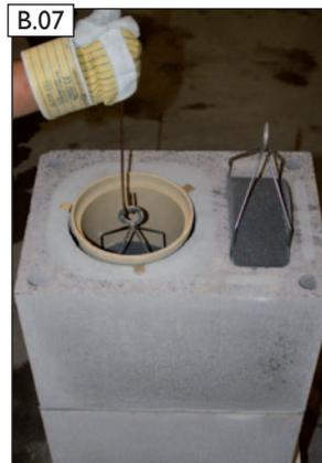
Nach dem Einbau des nächsten Keramikrohres wird der obere Schutzschwamm Abgas (3) mit Hilfe des Hakens (6) immer wieder bündig zur Muffe des versetzten Keramikrohres gezogen.
