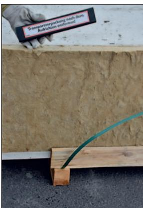
Zusätzliche Verpackungsstütze entfernen.
