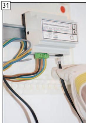
Ansicht Montage der LEDA LUC Datenbusleitung in der LEDA LUC Schalteinheit der bauteiligen Unterverteilung.
