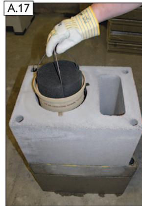
A.17 Oberen Schutzschwamm Abgas (3) bündig bis zur Rohrmuffe einstecken.
