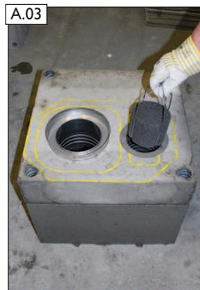
Unteren Schutzschwamm Zuluft (2) in Zuluftstutzen einstecken.
