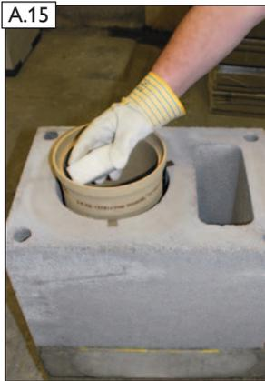
A.15 Muffenverbindung gem. der ABSOLUT-Versetzanleitung säubern.
