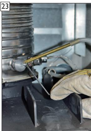
23 ... in die Öffnung des Verbindungselementes einstecken und mit der Fixierschraube sichern.
