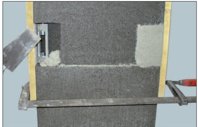
Aussparung der Spannelemente mit Mörtel der Mörtelgruppe MG(M5) Ila (Mauermörtel nach EN 998-2) verschließen.
