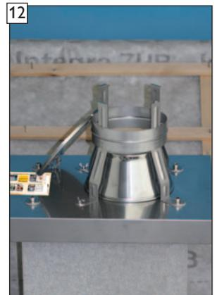
Der Revisionsdeckel ist mit einer Drahtschlinge, als „Absturzicherung“, verbunden. Die Drahtschlaufensicherung mind. einmal im Jahr überprüfen und ggf. erneuern.
