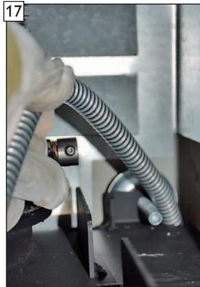
17 Metallschutzschlauch in der hinteren Ecke, zwischen Strahlungsblech und Brennkammer nach unten in den Bereich der Konvektionsluftöffnung der Brennkammer führen. Druckmessschlauch und Temperaturfühler vollständig aus dem Metallschutzrohr durchfädeln.
