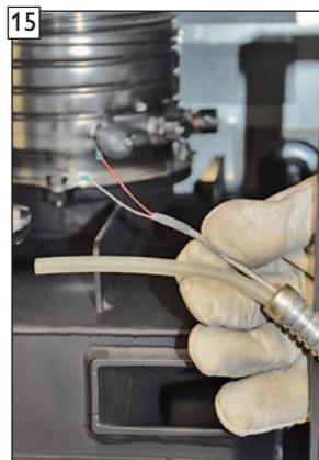
Druckmessschlauch und Temperaturfühler in Metallschutzschlauch einfädeln.
