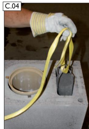
Mit dem Zugseil den unteren Schutzschwamm Zuluft (2) nach oben ziehen.
