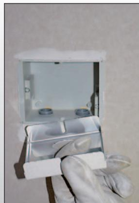
Abdeckung herausziehen. Weiter mit Montage des bauseitigen LEDA LUC Druckwächters.
