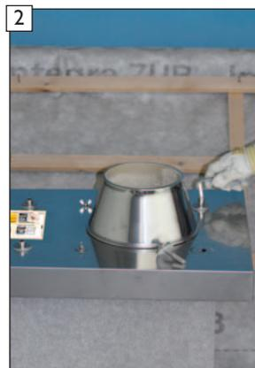
2 Beide Inbusschrauben der Zulufkopfplatte-Edelstahl mit Silikondichtungen und Unterlegscheiben an der Abgaszugseite heraus-schrauben.
