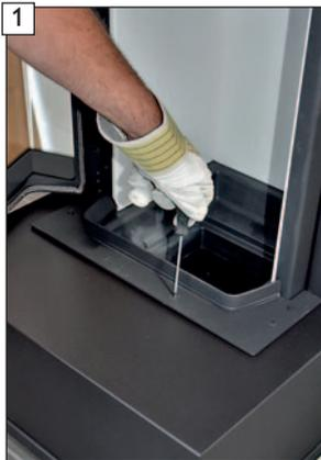
1 Fixierschrauben der Klemmschiene lösen.
