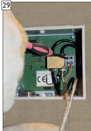
Temperaturfühler in der LEDA LUC Bedien- und Messeinheit gem. Schaltplan verklemmen.
