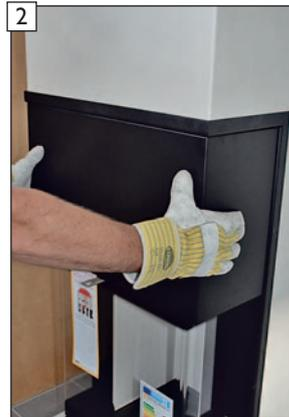
2 Obere Verkleidung der Brennkammer entfernen.
