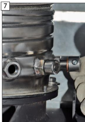
Verbindungselement für Temperaturfühler und ggf. notwendige Kupferringe zur richtigen Positionierung der Fixierschraube des Verbindungselementes dicht in die hintere Öffnung des Abgasadapters einschrauben.
