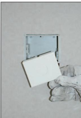
Abdeckung mit perforiertem Eingriffsloch in LEDA LUC Leerdose einsetzen.
