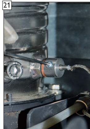
21 Temperaturfühler vollständig in die Öffnung des Verbindungselementes einstecken und mit der Fixierschraube sichern.
