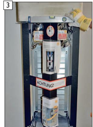
3 ... waagrechte Ausrichtung des Montagerahmens prüfen.
