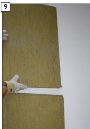
9 Obere Nutplatte in die Doppelfederplatte einstecken.
