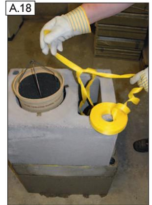
A.18 Äußeres Zugseilende mit dem unteren Schutzschwamm Zuluft (2) sicher verknotten.
