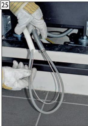
Druckmessschlauch und Temperaturfühler durch bauseitiges Leerrohr weiter bis in die LEDA LUC Bedien- und Messeinheit durchfädeln.
