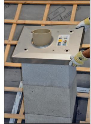
Zuluftkopfplatte wieder gem. Versetzanleitung montieren.
