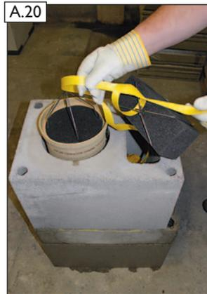
A.20 Inneres Zugseilende mit der Unterseite des oberen Schutzschwamms Zuluft (4) sicher verknotten und bündig bis zur Mantelsteinoberkante einstecken.
