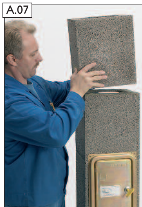
A.07 Zwei Mantelsteine versetzen.
