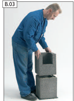
Dünnbettmörtel auftragen und Öffnungsstein versetzen.
