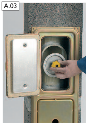
A.03 Revisionsverschluss aus dem AVANT-Paket einsetzen.
