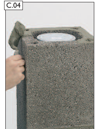
ROTEMPO auftragen, Fugenschutzdeckel auf Profilrohr auflegen und Dünnbettmörtel auftragen.
