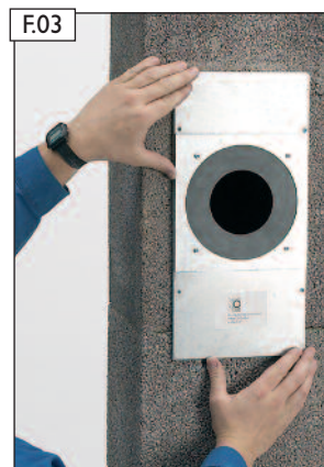
Anschlussblende einsetzen.
