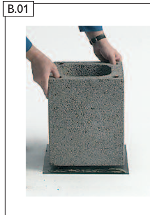
Mörtelbett vorbereiten, Feuchtesperre einlegen, Mörtel MG(M5) IIa (Mauermörtel nach EN 998-2) auftragen, Mantelstein in Mörtel versetzen.
