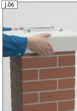
Zuluftkopfplatte aufsetzen und ...
