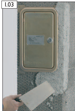
I.03 Putztür anputzen.
