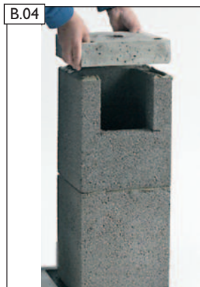
Sockelplatte in Dünnbettmörtel versetzen.
