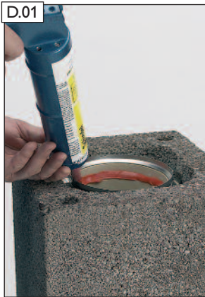
D.01 Schiedel ROTEMPO satt auf Profilrohr auftragen.
