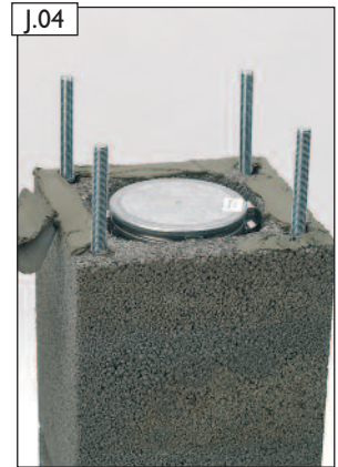
Mörtelbett MG(M5) IIa (Mauermörtel nach EN 998-2) auftragen.
