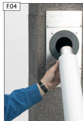
Ansicht der Montage einer konzentrischen Verbindungsleitung bei Gegenstrombetrieb.
