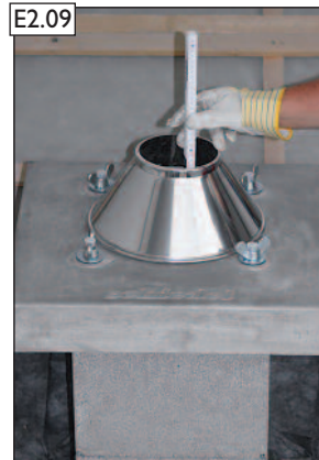
Differenzmaß zum letzten Keramikrohr ermitteln.
