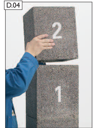
D.04 Zwei Mantelsteine versetzen.
