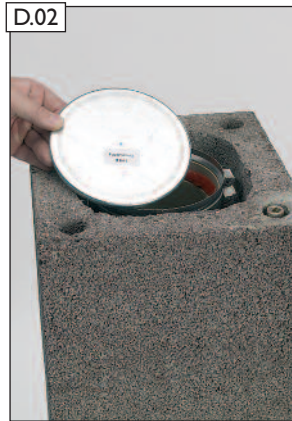
D.02 Fugenschutzdeckel auf Profilrohr auflegen.
