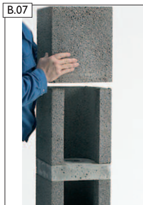
Folgenden Mantelstein in Dünnbettmörtel versetzen.
