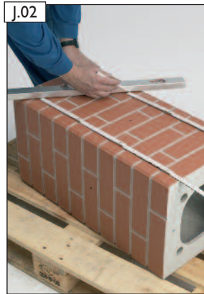
Maßübertragung auf den Stülpkopf.
