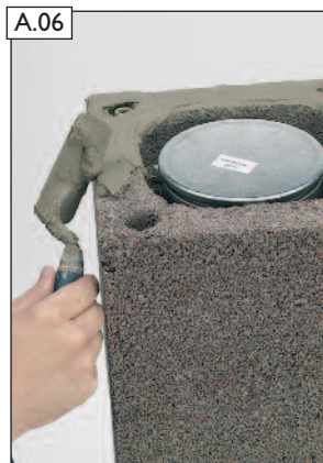
A.06 Dünnbettmörtel auftragen.
