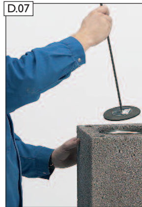
D.07 Profilrohrfuge mit Fugenglätter verstreichen.
