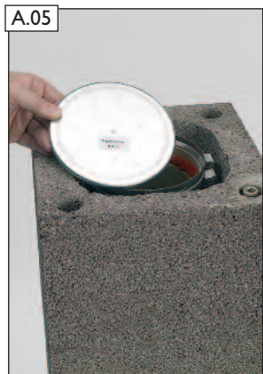
A.05 Fugenschutzdeckel auf Profilrohr auflegen.
