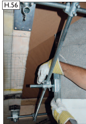
H.56 Spannwinkel ausrichten und vorfixieren.
