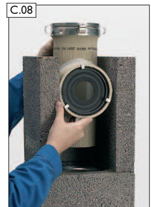
Rauchrohranschluss (RA) Formstück einsetzen.
