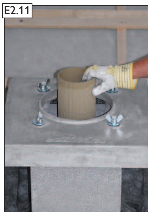
Differenzrohr gem. der AVANT-Versetzanleitung zuschneiden und versetzen.
