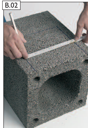
Öffnungsstein für Kondensatablauf anzeichnen (16 x 16 cm) und ausschneiden.
