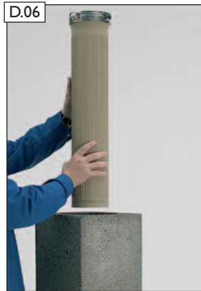
D.06 Profilrohr (L= 66 cm) einsetzen.
