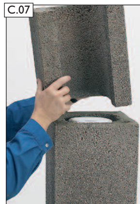
Öffnungsstein versetzen.
