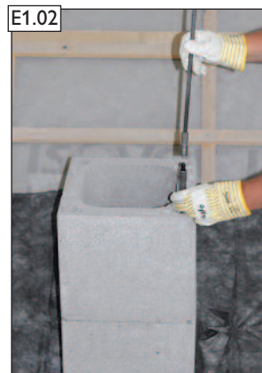
Zweiten Gewindestab mit Doppelhülse kraftschlüssig verschrauben.
