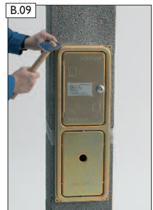
Fußblende aus dem Fußblendenpaket mittig zu den Öffnungen annageln.
