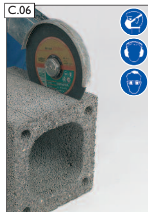
Mantelsteinöffnung mit Winkelschleifer herstellen. ACHTUNG! Beachten Sie bitte die Hinweise zum Arbeitsschutz auf Seite 2!
