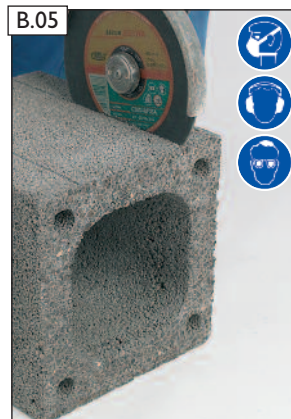
Öffnungsstein für AVANT Formstück PA herstellen (Ausschnittbreite 16 cm). ACHTUNG! Beachten Sie bitte die Hinweise zum Arbeitsschutz auf Seite 2!
