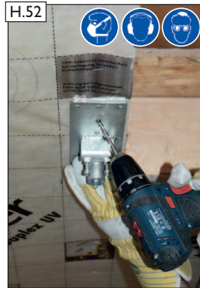
H.52 Sparrenhalter anhalten und Nagellöcher gemäß dem Nagelbild (siehe oben) vorbohren.
