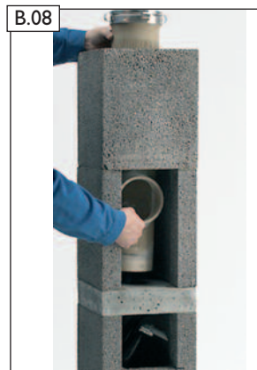
Putztüranschluss-Fuß (PA-Fuß) aus dem Formstückpaket PA einsetzen. Der Kondensatschlauch ragt durch die Öffnung der Sockelplatte.
