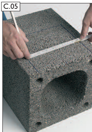
Öffnungsbreite am Mantelstein anzeichnen.
