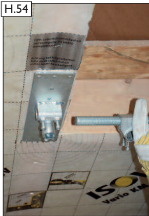
H.54 Gewindestange und 45° Spannwinkel wieder ein-fädeln und ausrichten.
