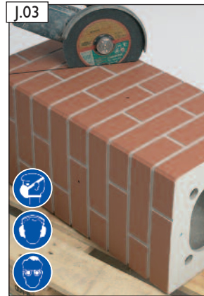
Mit Winkelschleifer zuschneiden. ACHTUNG! Beachten Sie bitte die Hinweise zum Arbeitsschutz auf Seite 2!
