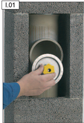
I.01 Revisionsverschluss einsetzen.
