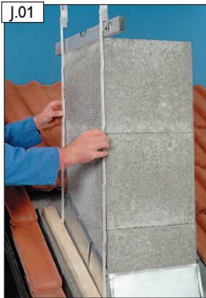
Ermittlung des Schrägschnittes.
