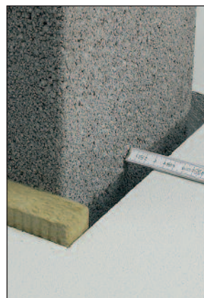
Deckenaussparung allseitig 3 cm größer als Mantelsteinmaß.
