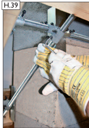
H.39 Zuerst Sparrenhalter und Spannwinkel (siehe Bild H.24 und H.25), danach Spannkreuz fixieren. Abreißschrauben anziehen bis Schraubkopf an der Sollbruchstelle abreißt.
