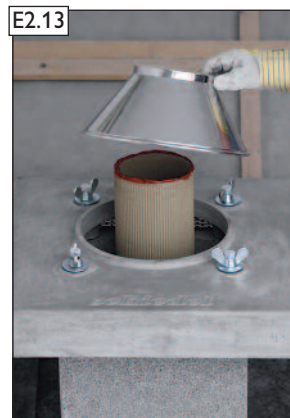
Abströmkonus (bündig bis Abdeckplatte) auf Endrohr versetzen.
