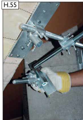
H.55 Gewindestange in Spann-kreuze des oberen und unteren Schornsteinhalters einfädeln und dabei das Spannkreuz mit dem 45° Spannwinkel mit auffädeln.
