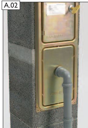
A.02 Ableitung zum Abwasserkanal bauseits erstellen.
