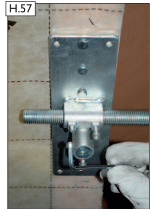
H.57 Gewindestange fixieren. Dazu die Abreißschrauben an bei den Sparrenhaltern mit Inbusschlüssel (F) anziehen bis der Schraubkopf an der Sollbruchstelle abreißt. Erst danach Spannwinkel fixieren (siehe Bild H.58).
