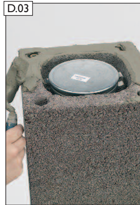
D.03 Dünnbettmörtel auftragen.
