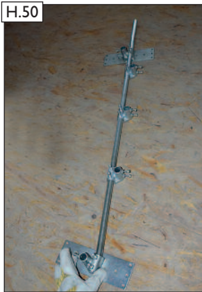
H.50 Zweiten Schornsteinhalter vorbereiten. Spannkreuze und Sparrenhalter lose auf die Gewindestange auf-fädeln.
