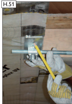
H.51 Aufgefädelt Einzelteile zum einrichten anhalten. Einbauposition für den Sparrenhalter markieren. Danach Einzelteile aus-fädeln.
