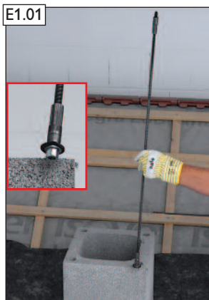
Gewindestab mit Dichtscheibe nach unten in Bewehrungszelle einstecken.
