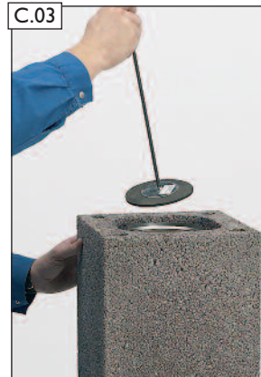
Profilrohr mit Fugenglätter verstreichen.
