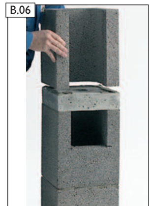
Öffnungsstein in Dünnbettmörtel versetzen.
