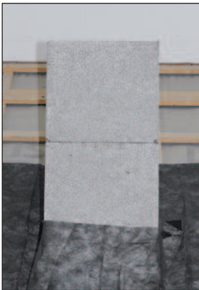
Ansicht vor Montagebeginn.
