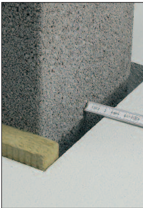
Deckenaussparung allseitig 3 cm größer als Mantelsteinmaß.
