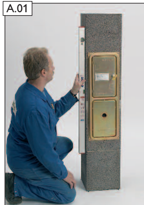
A.01 Mörtelbett vorbereiten, Feuchtesperre einlegen, Mörtel MG(M5) IIa (Mauermörtel nach EN 998-2) auftragen, Fertigfuß in Mörtel versetzen.
