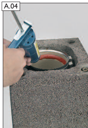
A.04 Schiedel ROTEMPO satt in die Muffe des Profilrohres auftragen.
