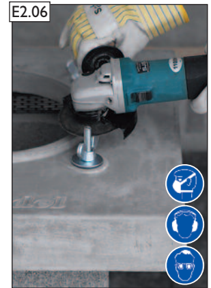
Überstehende Gewindestäbe können entfernt werden. ACHTUNG! Beachten Sie bitte die Hinweise zum Arbeitsschutz auf Seite 2!
