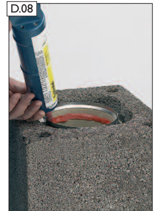
D.08 Standard-Versetzvorgang bis zur Mündung wiederholen.
