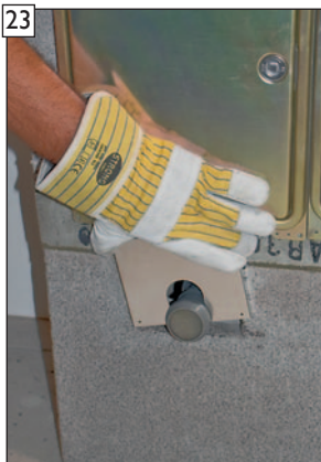
23 Abdeckblende aufstecken und ...
