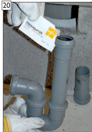
20 Gleitmittel in obere und untere HT-Einsteckmuffe einbringen.
