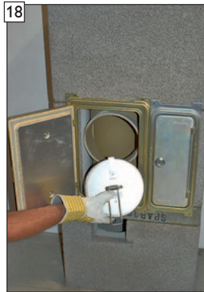
18 Revisionsverschluss einsetzen. (Bilddarstellung am Beispiel Revisionsverschluss „F“ für feste Brennstoffe)
