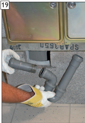
19 Vorderes HT-Rohrstück abziehen.
