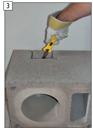
Wärmedämmung mit Dämmstoffsäge freischneiden.
