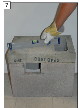
Sockelplatte lotrecht ausrichten und versetzen.
