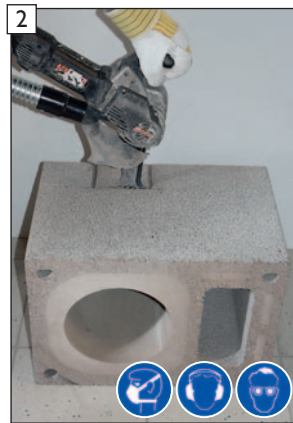
Öffnung herstellen. ACHTUNG! Beachten Sie bitte die Hinweise zum Arbeitsschutz auf Seite 2!
