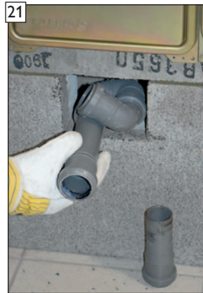
21 HT-Siphonteil eindrehen und auf Adapteranschluss des PA-Formstückes aufstecken.
