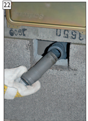
22 Vorderes HT-Rohrstück wieder in die untere HT-Einsteckmuffe einstecken.
