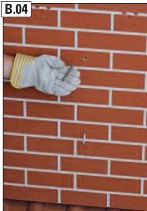
B.04 Gewindestifte in die seitlichen Gewindebuchsen des Stülpkopfes eindrehen.
