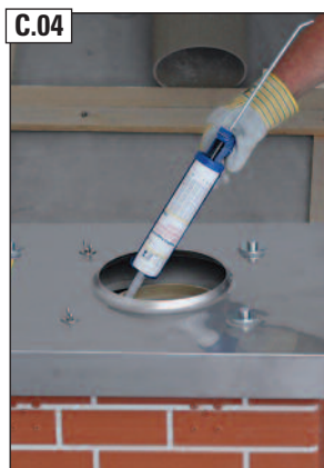
RAPID-fugendicht satt auftragen.
