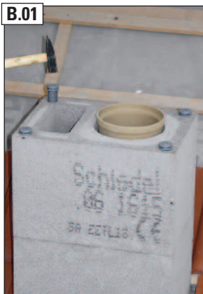
B.01 HEB-Spezialdübel in die Bewehrungskanäle einschlagen.
