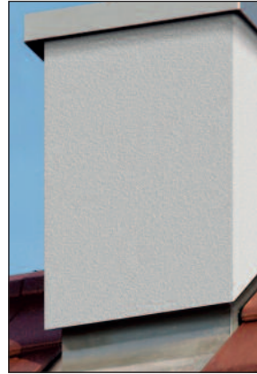
Ausführungsbeispiel bauseitiges Verwehrblech.
