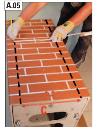
A.04 Ermittelte Abmessungen C des Mantelsteins mittig auf den Stülpkopf übertragen.
