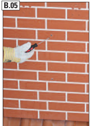
B.05 Gewindestifte kraftschlüssig verschrauben.
