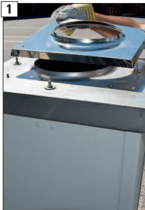
1 Adapterplatte auf Befestigungsbolzen auflegen.
