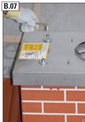
B.07 Befestigungsschrauben gem. HEB-Einbauanleitung montieren.
