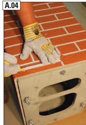
A.04 Ermittelte Abmessungen C des Mantelsteins mittig auf den Stülpkopf übertragen.
