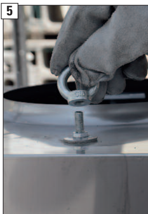
5 Ringösen können nun entfernt werden.
