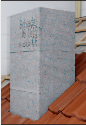
Ansicht vor Montagebeginn.
