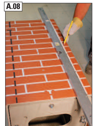
A.08 Längenmaß B (zzgl. der ermittelten Aufbauhöhe) an der angezeichneten Mantelsteinabmessung auftragen.
