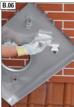
B.06 Befestigung für Regenhaube von der Edelstahlzuluftkopfplatte entnehmen.
