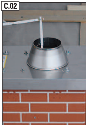
... Zuschnittlänge für das letzte Profilrohr ermitteln.
