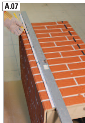
A.07 Längenmaß A (zzgl. der ermittelten Aufbauhöhe) an der angezeichneten Mantelsteinabmessung auftragen.
