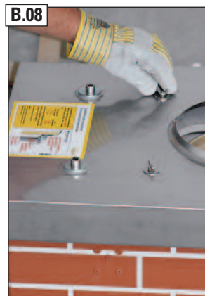
B.08 Befestigung für evtl. spätere Regenhaube montieren.
