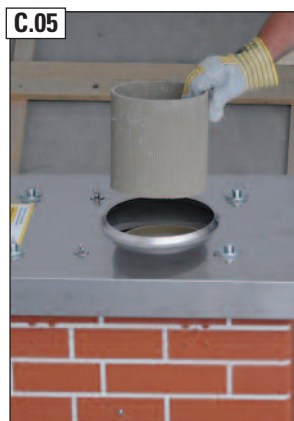
Zugeschnittenes Abschlussprofilrohr versetzen.
