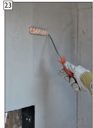
Grundierung StoPrim Plex aufbringen.
