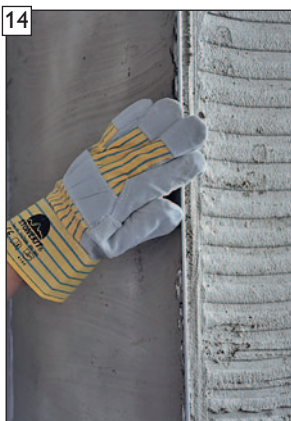
14 Eckschienenkanten noch im feuchten Zustand reinigen.
