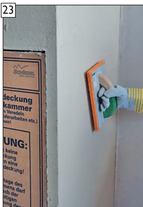
23 Oberfläche abreiben bzw. strukturieren.
