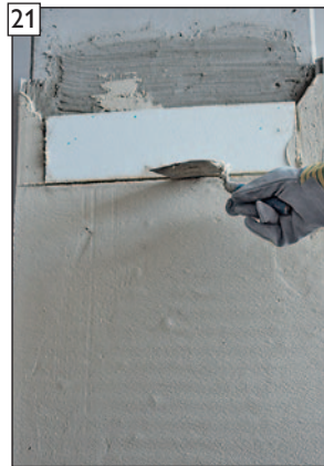
21 Ansicht „Abschneiden“ an der Konvektionsluftöffnung.
