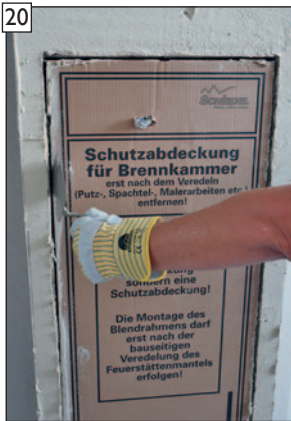
20 Oberputz an den Öffnungen abschneiden.
