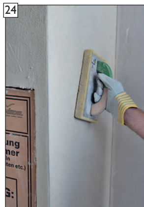
24 Gegebenenfalls Oberfläche im Anschluss filzen.
