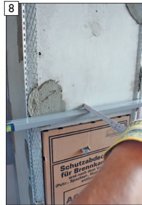
8 Erforderliche Putzdicke überprüfen und Eck- sowie Anschlussprofile entsprechend einstellen.
