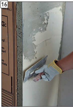
16 Oberputz auftragen und ...
