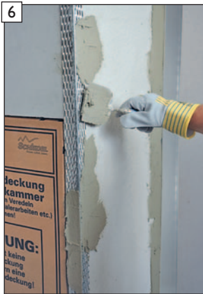
6 Eckprofile mit „maxit multi 280“ Haftbrücke ansetzen und ausrichten.
