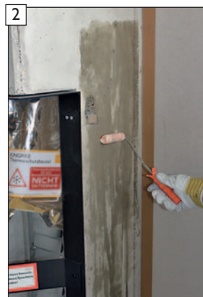
Grundierung Sopro GD 749 auf den Betonmantel aufbringen.
