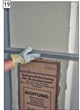
... mit Kardätsche abziehen und ...
