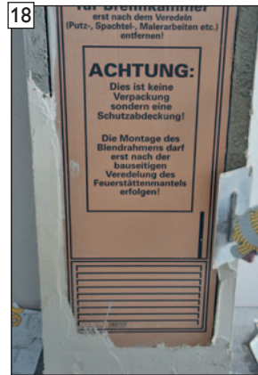
2ten Putzschichtauftrag an den Öffnungen vornehmen, ...
