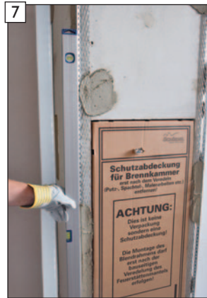
7 Eckprofile lotrecht ausrichten.
