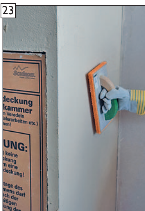
23 Oberfläche abreiben bzw. strukturieren.
