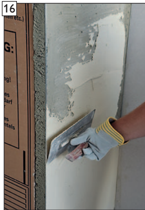
2ten Putzschichtauftrag aufbringen und ...
