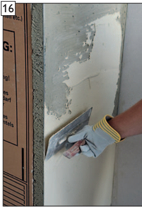
16 Spachtelauftrag Deck- schicht auftragen und ...
