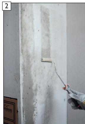
Vorreinigung des Betonmantels zur Staubbindung mit Wasser (z.B. mit Malerrolle).
