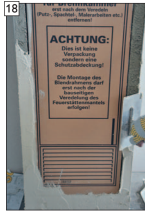
18 Oberputz an den Öffnungen auftragen und ...
