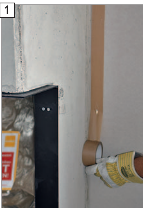
Trennband zur angrenzenden Leichtbauwand aufbringen.
