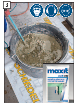
„maxit multi 280“ Haftbrücke gem. den Herstellervorgaben anmischen.
