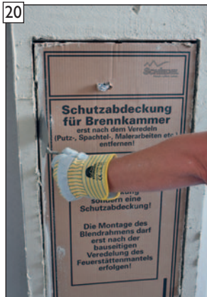
... 2ten Putzschichtauftrag an den Öffnungen abschneiden.
