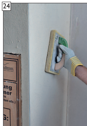
24 Gegebenenfalls Oberfläche im Anschluss filzen.
