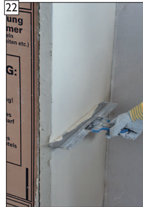
22 Oberfläche ggf. mit Flächenspachtel nach- arbeiten.
