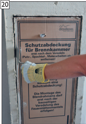
20 ... Oberflächenspachtel an den Öffnungen abschneide- den.
