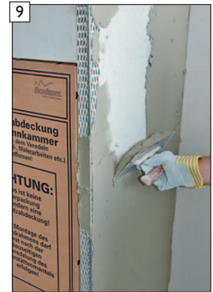
9 Haftbrückenauftrag vornehmen - max. Auftragsdicke 5 mm.
