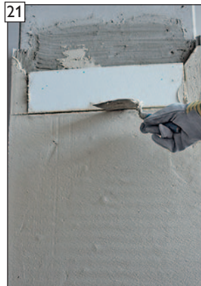
Ansicht „Abschneiden“ an der Konvektionsluftöffnung.
