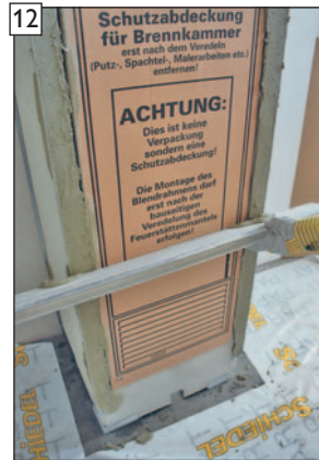
12 ... mit Kardätsche abziehen und ...
