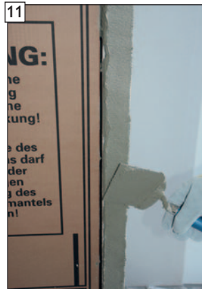
11 Haftbrückenauftrag zu den Öffnungen vornehmen, ...
