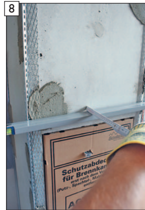
8 Erforderliche Spachteldicke überprüfen und Eck- sowie Anschlussprofile entsprechend einstellen.
