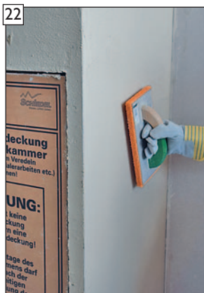
Oberfläche abreiben bzw. strukturieren.
