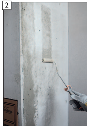
Vorreinigung des Betonmantels zur Staubbinding mit Wasser (z.B. mit Malerrolle).
