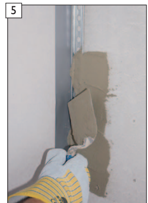
Anschlussprofile mit „Baumit multiContact MC 55 W“ Haftbrücke ansetzen und ausrichten.
