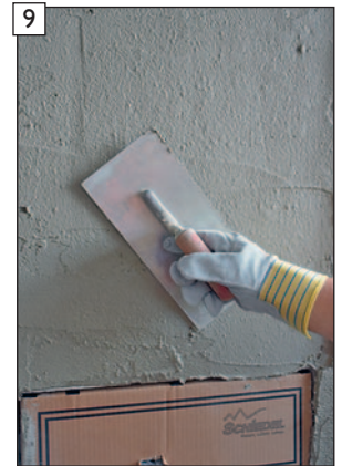
9 Haftbrückenauftrag vornehmen - max. Auftragsdicke 5 mm.
