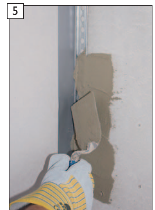
Anschlussprofile mit „maxit multi 280“ Haftbrücke ansetzen und ausrichten.
