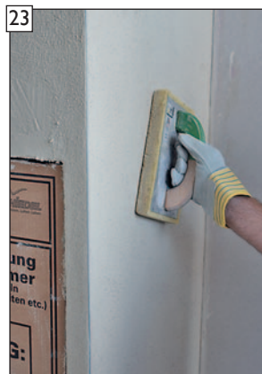
Gegebenenfalls Oberfläche im Anschluss filzen.
