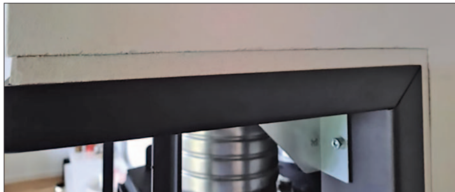
Fertigansicht mit eingebautem Blendrahmen
