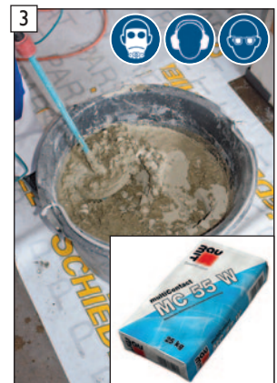
„Baumit multiContact MC 55 W“ Haftbrücke gem. den Herstellerangaben anmischen.
