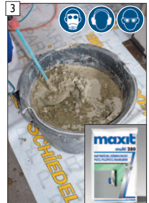
„maxit multi 280“ Haftbrücke gem. den Herstellervorgaben anmischen.
