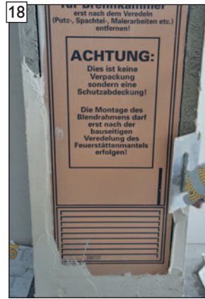
18 Spachtelauftrag an den Öffnungen vornehmen, ...
