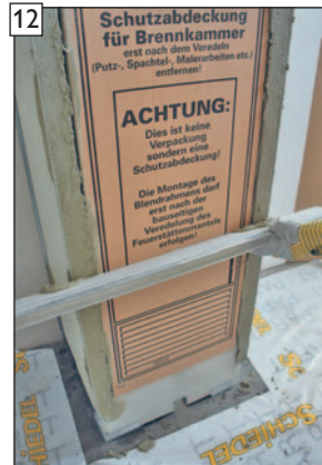
12 ... mit Kardätsche abziehen und ...
