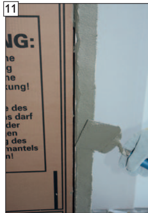
11 Haftbrückenauftrag zu den Öffnungen vornehmen, ...
