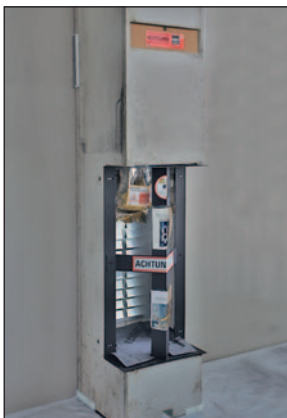
Ansicht vor Montagebeginn - Bekleidungsbeispiel mit KINGFIRE GRANDE SC
