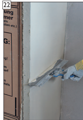
22 Oberfläche ggf. mit Flächenspachtel nacharbeiten.
