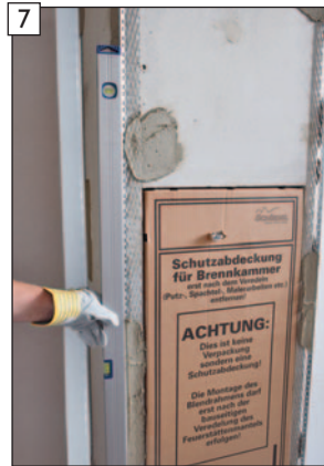
7 Eckprofile lotrecht ausrichten.
