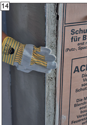
14 Eckschienenkanten noch im feuchten Zustand reinigen.
