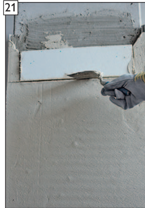
21 Ansicht „Abschneiden“ an der Konvektionsluftöffnung.
