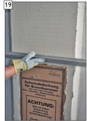
19 ... mit Kardätsche abziehen und ...
