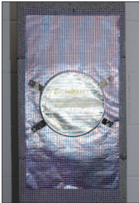
Ansicht vor Montagebeginn.
