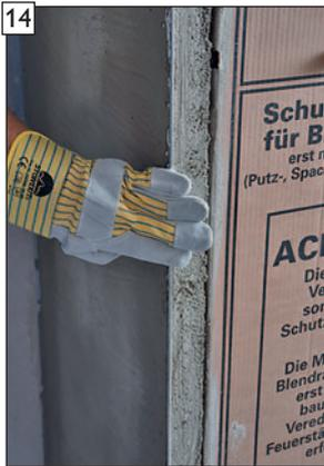
14 Eckschienenkanten noch im feuchten Zustand reinigen.
