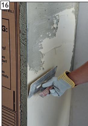
16 Spachtelauftrag Deckschicht auftragen und ...
