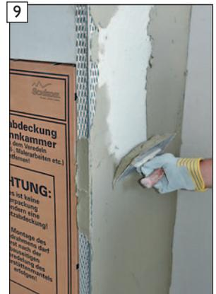
Haftbrückenauftrag vornehmen - max. Auftragsdicke 5 mm.
