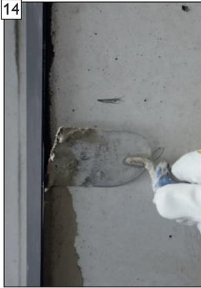
Die durch das Nachjustieren zum Betonkörper entstehenden Spalten zum Betonkörper ...
