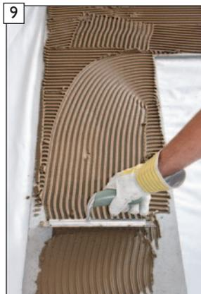
9 ... an der fermacell Powerpanel H<sub>2</sub>O Leichtbauplatte vornehmen.
