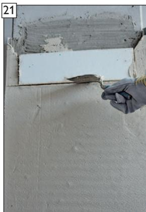
21 Ansicht „Abschneiden“ an der Konvektionsluftöffnung.
