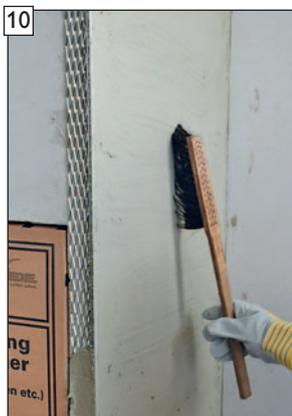
Oberflächenverzahnung für späteren Spachtelauftrag der Deckschicht in Haftbrücke einbringen (z.B. mit Putzbürste).
