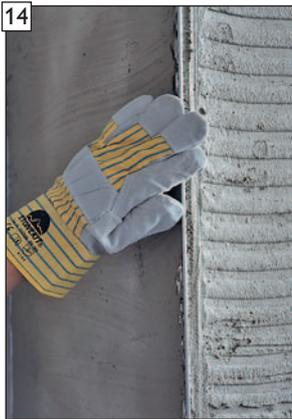
14 Eckschienenkanten noch im feuchten Zustand reinigen.
