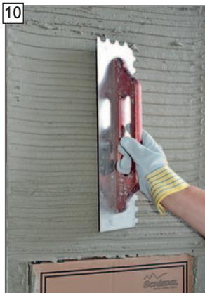
Oberflächenverzahnung für späteren Oberputz mit Zahntraufel (Zahnung ca. 10mm) in Haftbrücke einbringen.
