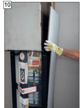
10 fermacell Powerpanel H<sub>2</sub>O Leichtbauplatte anbringen und ausrichten.
