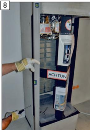
Montagerahmen unten mit Wasserwaagekontrolle nachjustieren und Inbusschrauben kraftschlüssig festziehen.
