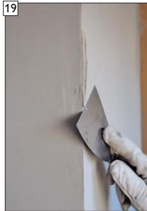
Spachtelreste an Kanten und Stoßstellen entfernen.
