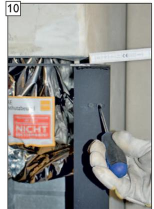
Überstand des Montagerahmens umlaufend kontrollieren. Rechts und links gleichmäßigen Überstand einstellen.
