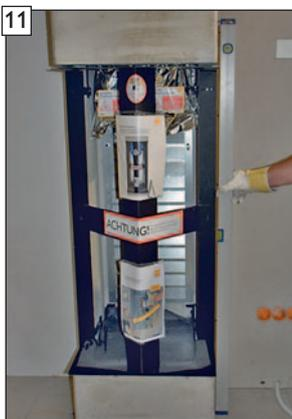
Wenn der Montagerahmen oben umlaufend ausgerichtet ist, den unteren Bereich, nur mit der Wasserwaage, ins Lot stellen.
