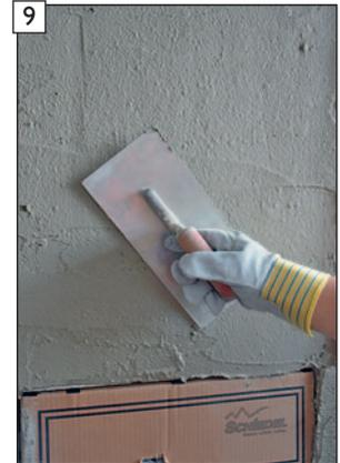
Haftbrückenauftrag vornehmen - max. Auftragsdicke 5 mm.
