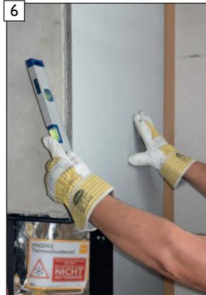
6 Probeanpassung am Betonkörper vornehmen.
