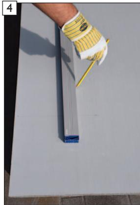
4 ... auf die fermacell Powerpanel H<sub>2</sub>O Leichtbauplatten übertragen.
