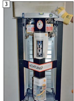
3 ... waagrechte Ausrichtung des Montagerahmens prüfen.
