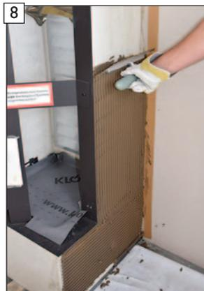
8 Kleberauftrag im „Floating-Buttering-Verfahren“ für die erste Seitenwand am Betonmantel und ...
