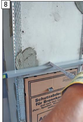
Erforderliche Putzdicke überprüfen und Eck- sowie Anschlussprofile entsprechend einstellen.
