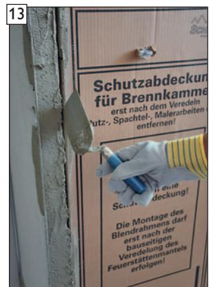
... den Haftbrückenauftrag im Anschluss sofort zur Schutzpappe hin abschneiden.
