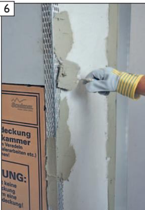
Eckprofile mit „maxit multi 280“ Haftbrücke ansetzen und ausrichten.
