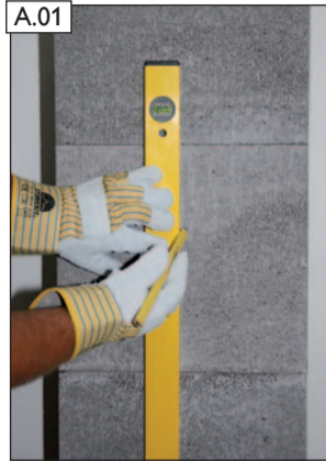
A.01 Anschlusshöhe der gewünschten Rauchrohröffnung ermitteln.
