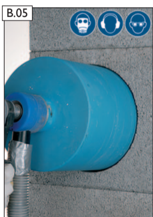
B.05 Mantelsteinöffnung jetzt mit größerer Bohrkronen vollständig aufbohren. WICHTIG! Profilrohr dabei nicht beschädigen oder anbohren!
