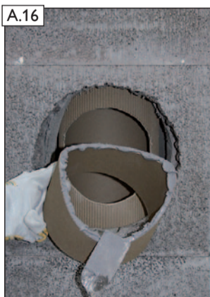
A.16 Schiedel-Fugenkitt auf Rauchrohrstutzen auftragen.
