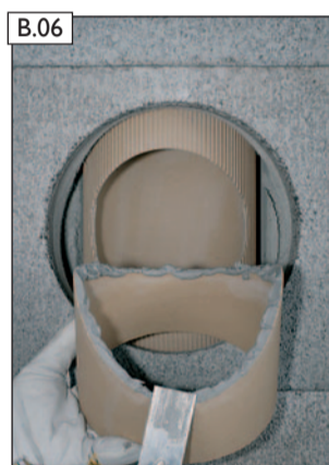
B.06 Nach Reinigung beider Kittflächen Schiedel-Fugenkitt auf die Rauchrohrstutzen auftragen.
