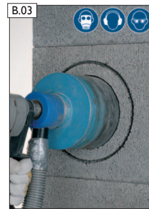
B.03 Für den inneren Querschnitt, mit kleiner Bohrkronen, vorsichtig durch Mantelstein und Profilrohr bohren.
