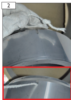
2 An einem Ende der E-Glas Flachdichtung einen Knoten binden. Das Knotenende der E-Glas Flachdichtung in den Knotenfänger des Anschlussfutters einhängen.
