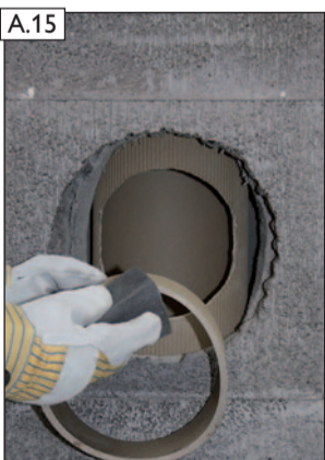
A.15 Rauchrohrstutzen mit feuchtem Schwamm säubern.
