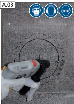
A.03 Mit Bohrmaschine und kleinem Steinbohrer (ø8mm) an der Markierung vorbohren. Dann mit größerem Steinbohrer (ø12mm) nachbohren.
