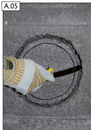
A.05 Schaumdämmung im Mantelstein mit dem ABSOLUT-Sägemesser aufschneiden.
