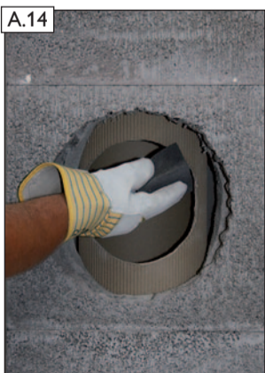
A.14 Schnittfläche mit feuchtem Schwamm säubern.
