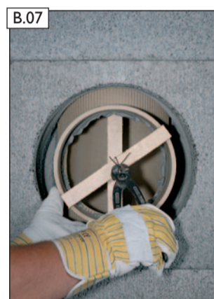
B.07 Rauchrohrstutzen am Profilrohr feströdeln.
