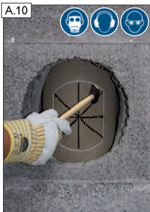
A.10 Profilrohrteile vorsichtig mit Hammer entfernen.
