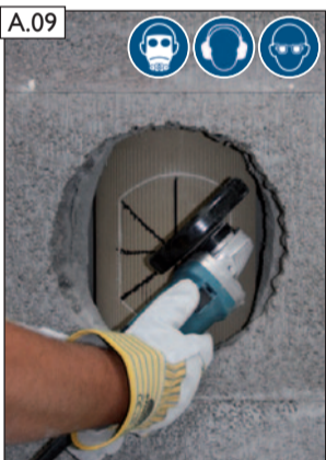
A.09 Das Profilrohr zuerst senkrecht entlang der Profile einschneiden, danach einen waagrechten Schnitt vornehmen.
