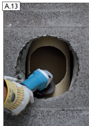
A.13 Unebenheiten an der Sollbruchstelle mit Winkelschleifer nacharbeiten.
