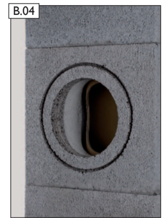
B.04 Ansicht durchbohrter Mantelstein und Profilrohr.
