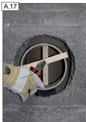
A.17 Rauchrohrstutzen am Profilrohr feströdeln.
