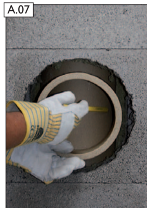
A.07 Rauchrohrstutzen als Schablone verwenden und entlang des inneren Durchmessers anreißen.
