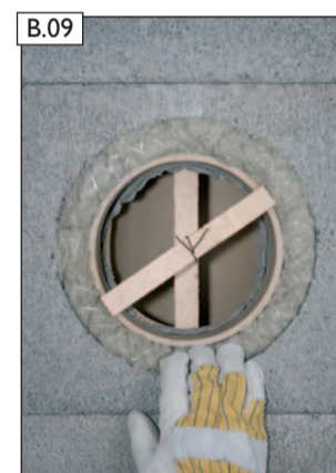
B.09 Rauchrohrstutzen mit Dichtschur abdichten.
