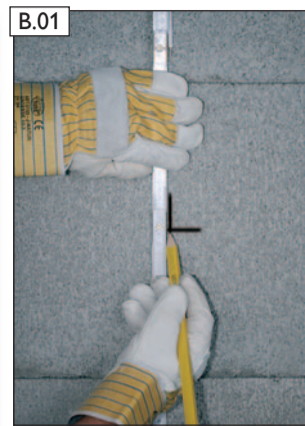
B.01 Mittelpunkt der gewünschten Mantelsteinöffnung anreißen.
