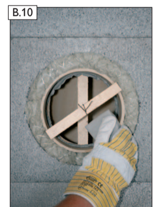
B.10 Kittreste vorsichtig mit Schwamm entfernen.
