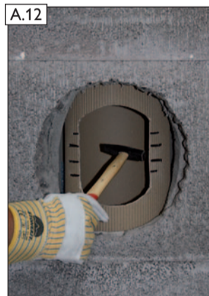
A.12 Restliche Profilrohrteile vorsichtig mit Hammer entfernen.
