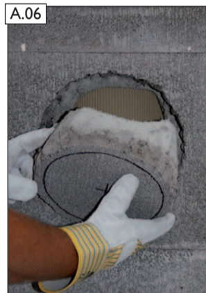
A.06 Mantelsteinsegment herausnehmen und Öffnung säubern.
