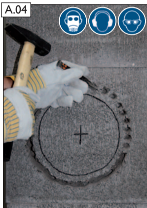
A.04 Evtl. verbleibende Reststege mit kleinem Meißel durchtrennen.
