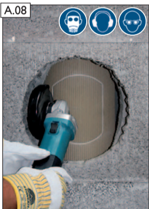
A.08 Entlang der Markierung Sollbruchstelle mit Winkelschleifer anschneiden. Seitlich nicht erreichbarer Bereich später bearbeiten (Bild A.12 und A.13).
