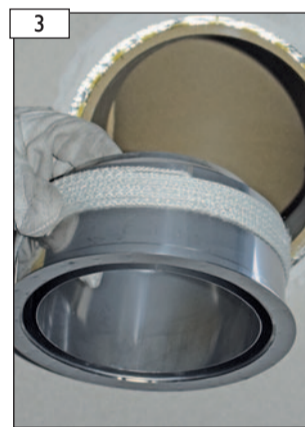
3 E-Glas Flachdichtung spiralförmig und straff um das Anschlussfutter wickeln. WICHTIG! Ende der E-Glas Flachdichtung am Schluss festhalten!
