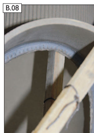
B.08 ACHTUNG! An der Oberseite zum Rauchrohrstutzen ist immer eine Abtropfkante auszubilden!
