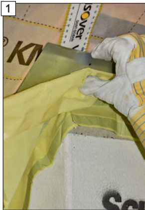
1 Nagelblechwinkel bündig zur Schornsteinecke ansetzen und ...
