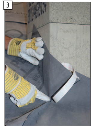
3 Schutzstreifen am Butyl-Tape abziehen. ACHTUNG! Unbeabsichtigtes Ankleben dabei vermeiden - starke Klebewirkung.
