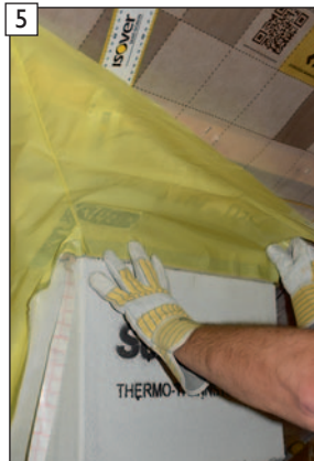
5 Butyl-Tape dicht anbringen. WICHTIG! Auf geschlossene und gut angepresste Ecken achten!
