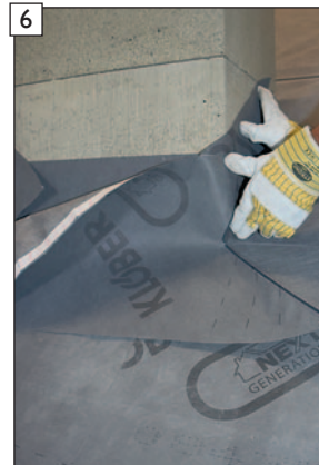
6 Nächsten Folienwinkel wieder bündig und winklig zur Schornsteinecke ansetzen und ...
