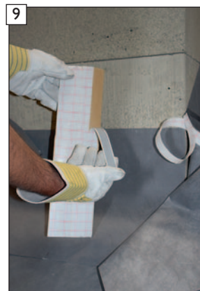
9 Einen Butyl-Tapestreifen für den Stoßverbund abziehen und ...
