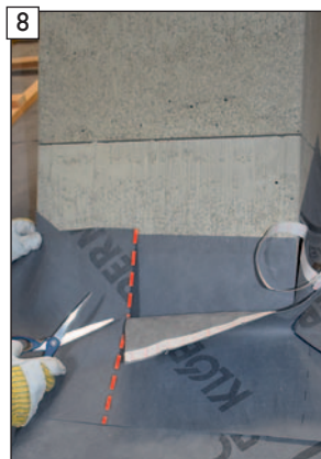
8 Den überlappenden USB-Folienwinkel etwa mittig am Schornstein für die Stoßverklebung einkürzen.
