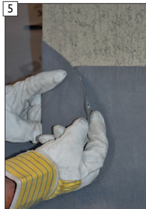
5 USB-Folienecke dicht zusammenkleben und einfalten.
