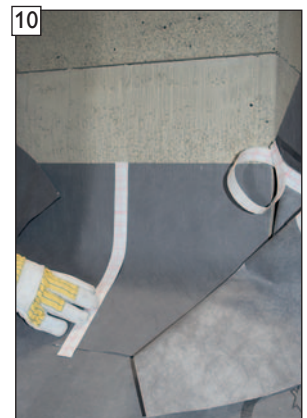
10 ... auf dem unteren USB-Folienwinkel verkleben. ACHTUNG! Unbeabsichtigtes Ankleben dabei vermeiden - starke Klebewirkung.
