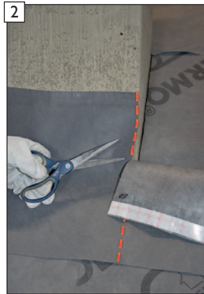
2 ... überstehende USB-Folie bündig mit Schornstein einkürzen.
