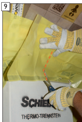
9 DB-Folienwinkel etwa mittig am Schornstein für die Stoßverklebung einkürzen.
