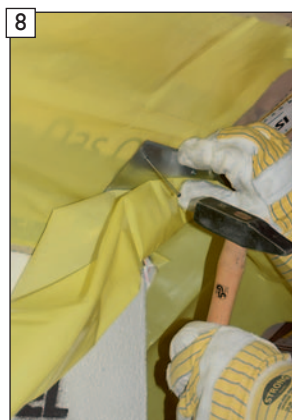
8 ... befestigen. ACHTUNG! DB-Folie dabei nicht beschädigen!
