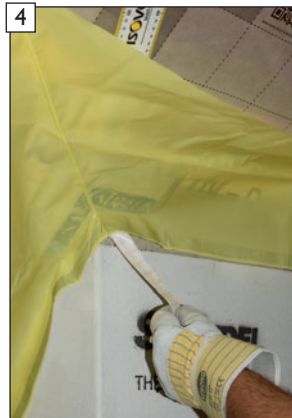
4 Schutzstreifen am Butyl-Tape abziehen. ACHTUNG! Unbeabsichtigtes Ankleben dabei vermeiden - starke Klebwirkung.
