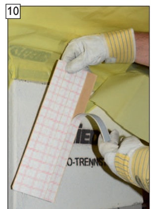
10 Einen Butyl-Tapestreifen für Stoßverbindung abziehen und ...
