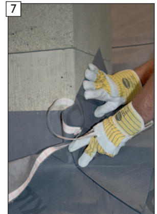
7 ... nicht überlappende Winkelseite wie bereits beschrieben befestigen.
