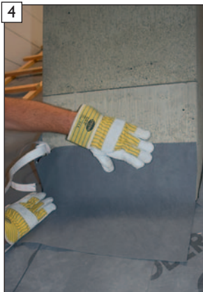
4 Butyl-Tape dicht anbringen. WICHTIG! Auf geschlossene und gut angedrückte Ecken achten!
