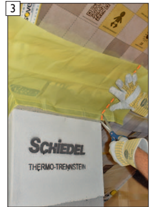
3 Überstehende DB-Folie bündig mit Schornstein einkürzen.
