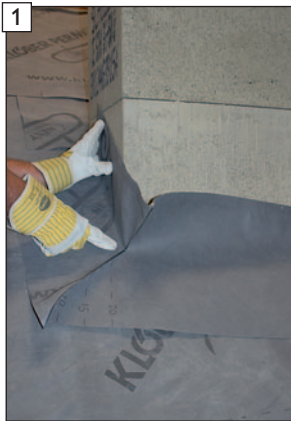
1 USB-Folienwinkel bündig und winklig zur Schornsteinecke ansetzen und ...
