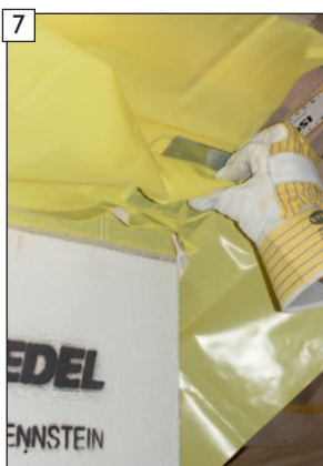
7 Nächsten Folienwinkel mit dem Nagelblechwinkel an der bündig geschnittenen Folienseite wieder bündig zur Schornsteinecke ansetzen und ...
