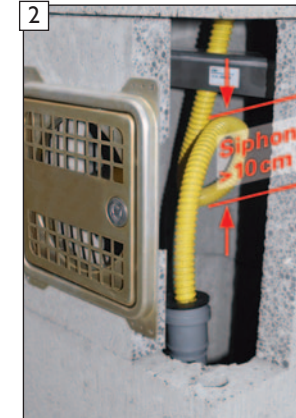
2 Ableitung mit HT-Rohren DN40 mit Aufweitungen zum Bodenablauf innerhalb des Schornsteins. Hierzu die Dichtung (A) der Blende (B) in die Muffe des HT-Rohres DN40 einbringen.
