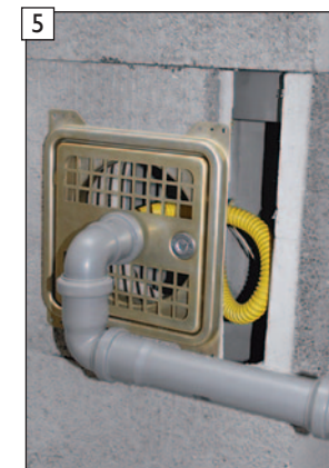
5 Ableitung mit HT-Rohren DN40 mit Aufweitungen zum Bodenablauf vor dem Schornstein.
