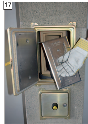
17 Putztür öffnen und Revisionsverschluss abnehmen.
