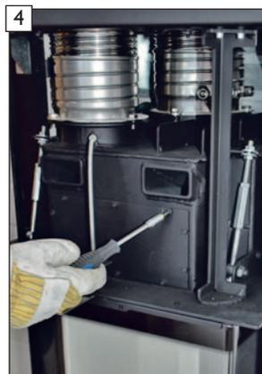
Befestigungsschraube am Revisionsverschluss entfernen.
