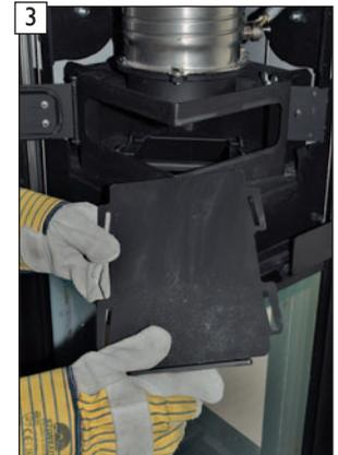
3 Einlegeboden aus der Revisionsöffnung entfernen.
