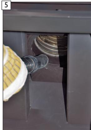
Oberen Bereich der Brennkammer gründlich und vollständig reinigen, speziell um den Bereich des Haltebleches.
