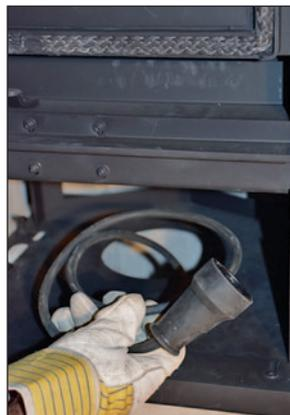
Über den Revisionsdeckel können bauseitige Arbeiten zum 230V-Stromanschluss für die optionale Stromversorgung der INflame! LR oder Verlegearbeiten für das LEDA LUC Anschlusskabel einfach vorgenommen werden.
