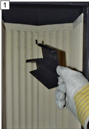
1 Rechten Kombihaltewinkel auf die Oberseite der Seitenkeramikverkleidung der Brennkammer auflegen.
