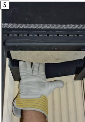
5 Obere Umlenplatte soweit zurückschieben bis diese in der Anschlag Nase des Kombihaltewinkels einrastet.
