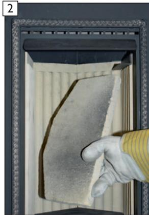
2 Obere Umlenplatte steil über dem Kombihaltewinkel einführen und quer drehen.
