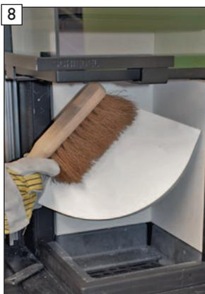
8 Prallplatte leicht anheben, aus der Brennkammer entfernen und mit Handfeger reinigen.
