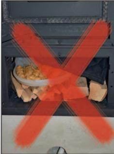
Der Bereich der Zuluftöffnung darf nicht zugestellt, verschlossen oder als Ablagefach verwendet werden!
