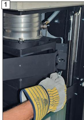
1 Flügelmutter der Revisionsklappe entfernen und Revisionsklappe öffnen.
