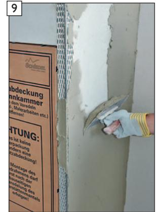
9 Haftbrückenauftrag vornehmen - max. Auftragsdicke 5 mm.
