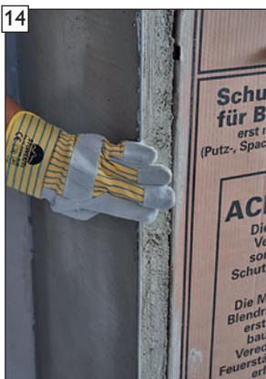
14 Eckschienenkanten noch im feuchten Zustand reinigen.
