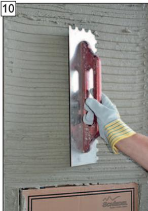
10 Oberflächenverzahnung für späteren Oberputz mit Zahntraufel (Zahnung ca. 10mm) in Haftbrücke einbringen.
