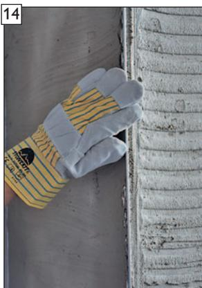
14 Eckschienenkanten noch im feuchten Zustand reinigen.
