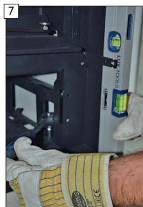
7 Ggf. ist hierbei mittels der vier Justierschrauben (B) eine entsprechende Nachjustierung der KINGFIRE RONDO SC-Brennkammer vor dem kraftschlüssigen Anziehen der beiden Verbindungsschrauben (A) vorzunehmen.
