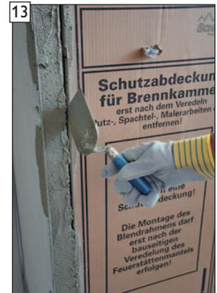
13 ... den Haftbrückenauftrag im Anschluss sofort zur Schutzpappe hin abschneiden.
