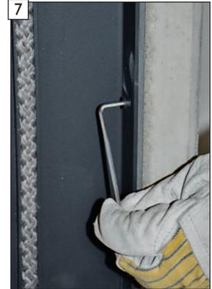
Mit Inbusschlüssel alle Befestigungsschrauben am Brennraumrahmen vollständig zurückschrauben.
