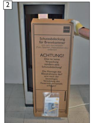
2 Werkseitige Schutzabdeckung entfernen.
