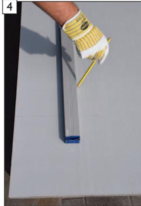
4 ... auf die fermacell Powerpanel H<sub>2</sub>O Leichtbauplatten übertragen.
