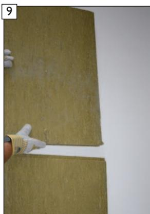
9 Obere Nutplatte in die Doppelfederplatte einstecken.
