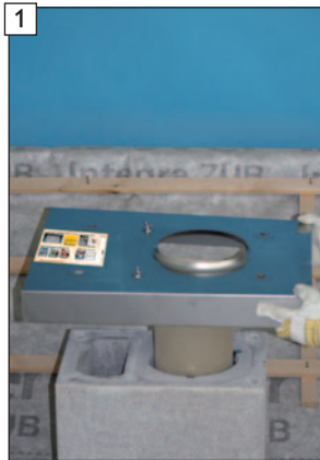
Zuluftkopfplatte-Edelstahl auflegen.
