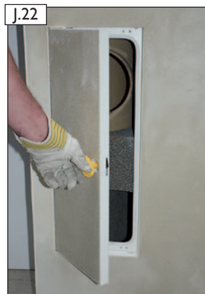
Funktionskontrolle! Überprüfen Sie die Schließung der Blower-Door Design-Tür und entfernen Sie ggf. Putzreste an Türblatt und Zarge.
