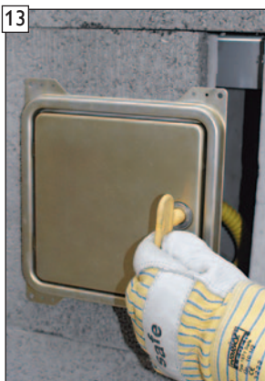
BlowerDoor Kondensatblendentürblatt abnehmen.
