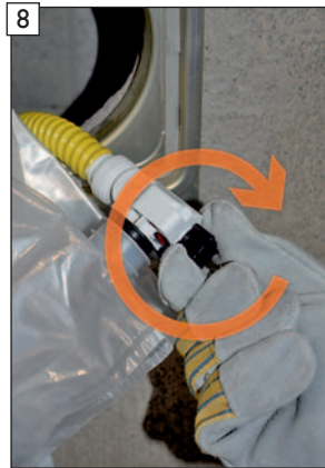
Verriegelung des BIB-Connectors im Uhrzeigersinn schließen.
