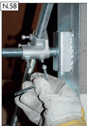
Spannwinkel an den Schornstein drücken. Abreißschrauben anziehen bis der Schraubkopf an der Sollbruchstelle abreißt.
