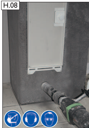
Bauseitige Öffnungsbohrung herstellen.
