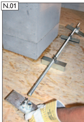
N.01 Ersten Schornsteinhalter vorbereiten. Spannwinkel und Sparrenhalter lose auf die Gewindestange auf-fädeln.
