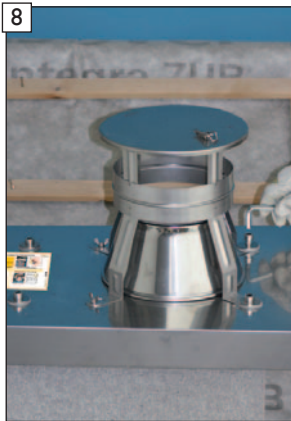
Regenhaube „EAGLE“ mit der Zuluftkopfplatte-Edelstahl verschrauben.
