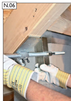
N.06 Gewindestange und Spann-winkel wieder einfädeln.
