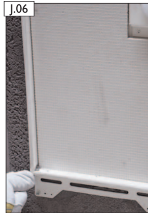
J.06 Ansicht unterer Türscharnierbereich mit bauseits zurückgeschnittener Schutzdichtung im Bereich des Türscharniers.
