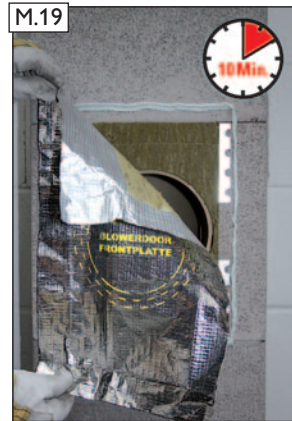
Spezial-Alugewebefolie innerhalb von 10 Minuten ausgerichtet ansetzen und ...
