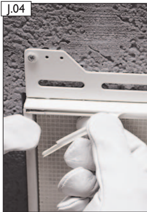
J.04 Detailansicht Bereich Türscharnier mit bauseits zurückgeschnittener Schutzdichtung im Bereich des Türscharniers.
