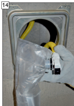
Kondensatauffangbeutel vorsichtig herausziehen.
