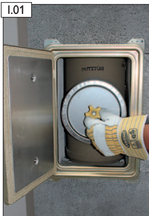
I.01 Standardrevisionsverschluss einsetzen.
