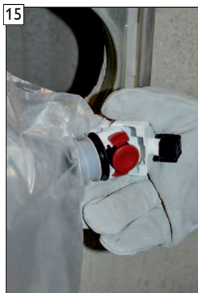
Verriegelung des BIB-Connectors öffnen und BIB-Anschlussrohr mit dem Kondensatauffangbeutel aus dem Kuppelungsteil herausziehen.
