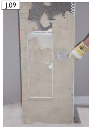
J.09 Anbringen des bauseitigen Unterputzes auf den Design-Fertigfuß und den Putzträger der BlowerDoor Design-Tür.
