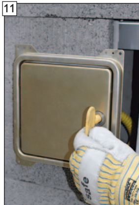
Kondensatblendentürblatt wieder verschließen.
