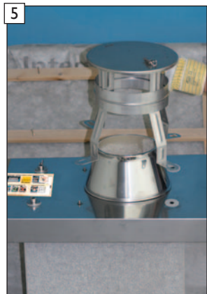
Silikondichtungen auf Zuluftkopfplatte-Edelstahl auflegen. Regenhaube „EAGLE“ aufsetzen.
