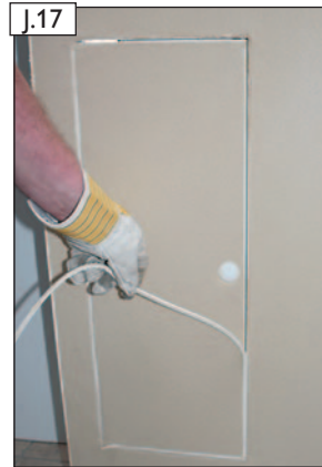
Schutzdichtung dabei immer vorsichtig und langsam herausziehen.
