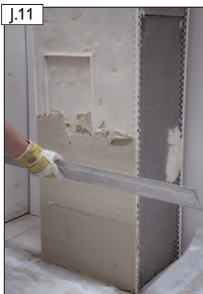
J.11 Bauseitigen Oberputz auftragen.
