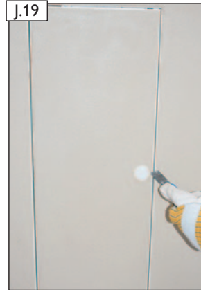
Abdeckkappe des Türverschlusses probeweise vorsichtig abziehen.
