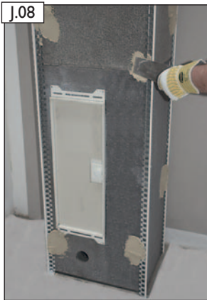
J.08 Anbringen der bauseitigen Putzschienen.
