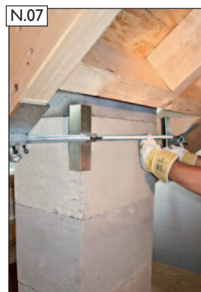
N.07 Spannwinkel an beiden Seiten ausrichten.
