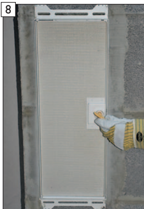
BlowerDoor Design-Platztür- blatt wieder verschließen.
