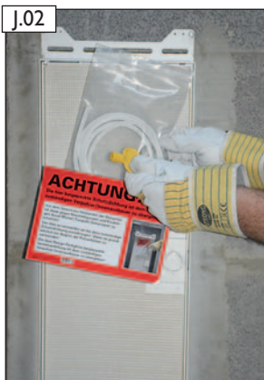
J.02 Transportbeutel mit Schutzdichtung von der BlowerDoor Design-Putztür entfernen.
