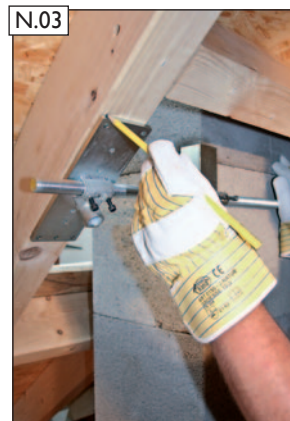
N.03 Einbauposition für den Sparrenhalter markieren. Danach Einzelteile aus-fädeln.
