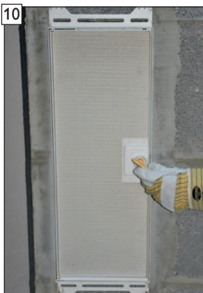
BlowerDoor Design-Platz- tür öffnen.
