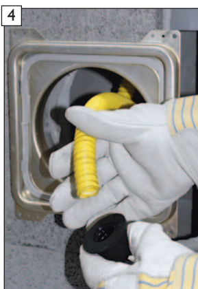
4 Adapter für HT-Rohrverbindung DN40 vom Siphonschlauch abschrauben.
