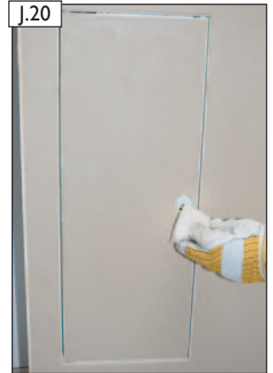
Putzkante zur Abdeckkappe ggf. mit Schwamm nacharbeiten.
