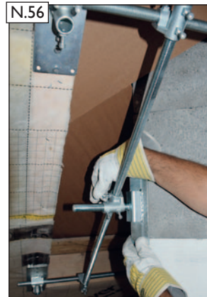
Spannwinkel ausrichten und vorfixieren.
