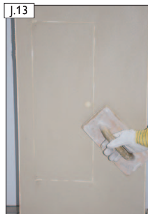
J.13 ... dabei die Schutzdichtung bündig freireiben.
