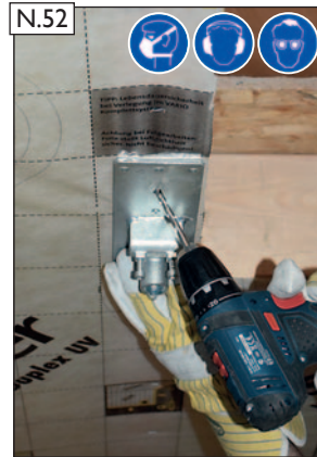
Sparrenhalter anhalten und Nagellöcher gemäß dem Nagelbild (siehe oben) vorbohren.
