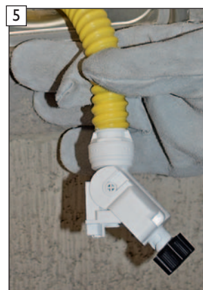
5 Kupplungsteil mit verriegelbarem BIB-Connector auf den 3/4" Siphonschlauch aufstecken.
