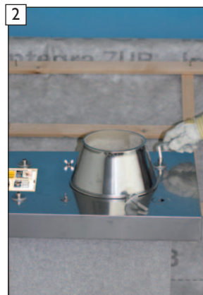
Beide Inbusschrauben der Zuluftkopfplatte-Edelstahl mit Silikonichtungen und Unterlegscheiben an der Abgaszugseite heraus-schrauben.
