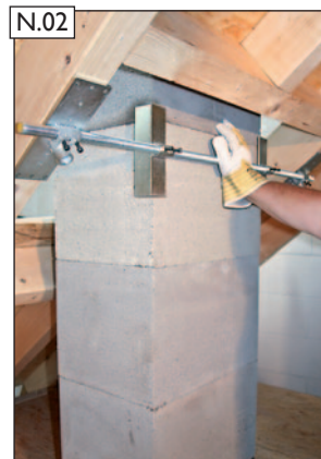
N.02 Aufgefädelt Einzelteile zum einrichten anhalten.
