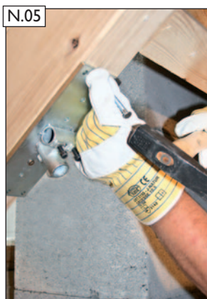
N.05 Sparrenhalter mit Kamm-nägeln (D) ausnageln.
