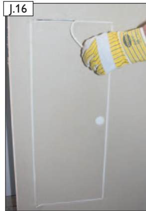
Sobald der Oberputz beginnt „anzuziehen“ ist die Schutzdichtung zu entfernen.
