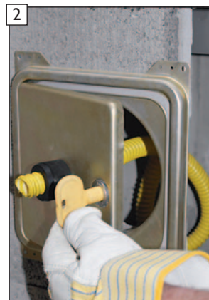
2 Kondensatblendentürblatt öffnen.
