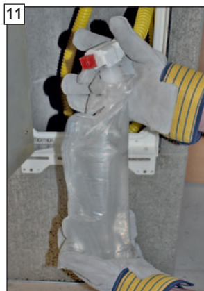
Kondensatauffangbeutel vorsichtig herausziehen.
