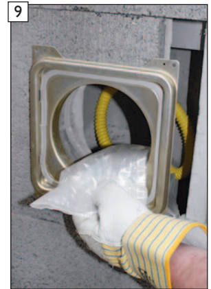
Siphonschlauch und Kondensatauffangbeutel in Schornsteinfuß einschieben.
