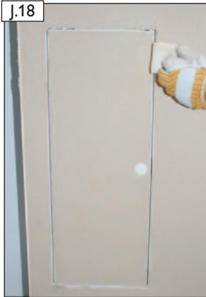
Putzkanten ggf. vorsichtig mit Schwamm nacharbeiten.
