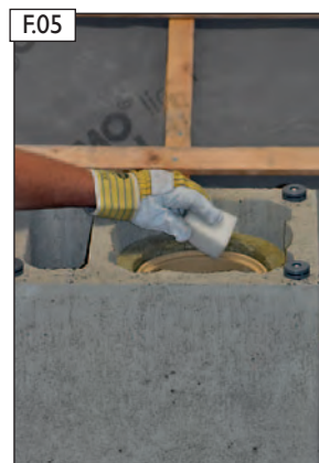
Unterseite des Schamotte Rohrs säubern.
