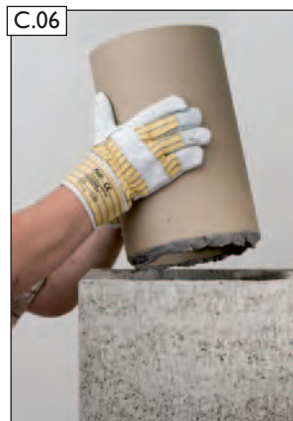
Schamotterohr versetzen.
