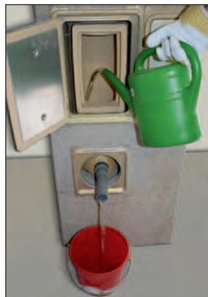
Kondensatteller und Siphonschlauch spülen.
