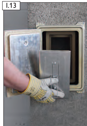
I.13 Vorsatzschale aus dem SIH-Anschlusspaket entnehmen und in den Putztüranschluss einsetzen.
