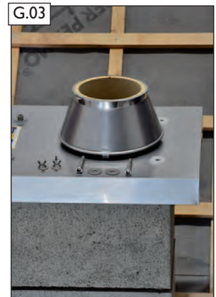
Silikondichtungen auf Zuluftkopfplatte-Edelstahl auflegen. Regenhaube „EAGLE“ aufsetzen.
