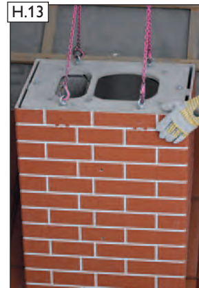
H.13 Stülpkopf versetzen und lotrecht ausrichten.
