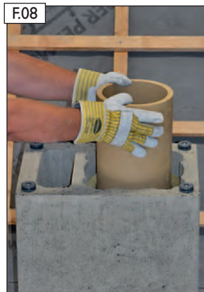
F08 Abschlussrohr (ohne Dämmschale) versetzen.
