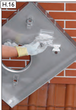
Befestigung für Regenhaube von der Edelstahlzuluftplatte entnehmen.
