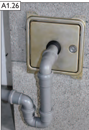
Fertigansicht mit bauseitigem Siphon.
