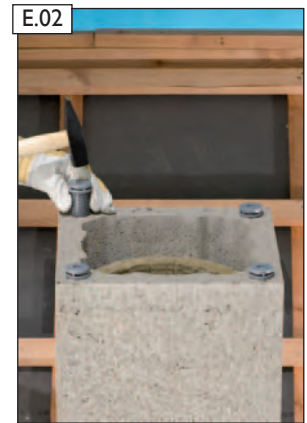
Ausführung mit Abdeckplatte: Dübel im obersten Mantelstein einsetzen.
