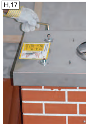
Befestigungsschrauben gem. HEB-Einbauanleitung montieren.
