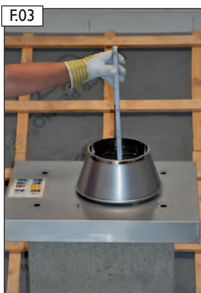
Zuluftkopfplatte und Abströmkonus lose auflegen und Zuschnittlänge für Abschlussrohr (ohne Dämmschale) ermitteln.
