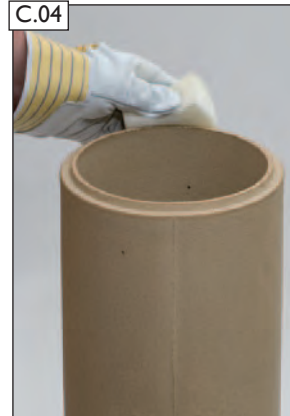
Unterseite des Schamotte-rohrs säubern.
