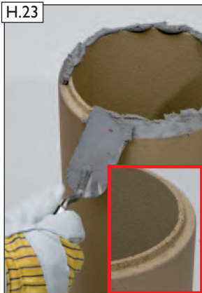
Fugenkitt auf Rohrunterseite des Abschlussrohres auftragen.
