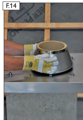
F14 Konus bis ca. 2-3 cm auf Abdeckplatte schieben.
