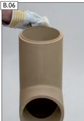
B.06 Unterseite des Rauchrohr- anschluss-Formstückes (RA-Formstück) säubern.
