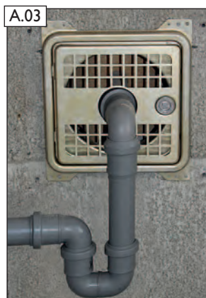
Kondensatableitung zum Abwasserkanal bauseits herstellen (HT-Rohr DN40 bauseits bereitstellen).
