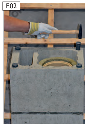
HEB-Spezialdübel in die Bewehrungskanäle des Mantelsteins einschlagen.
