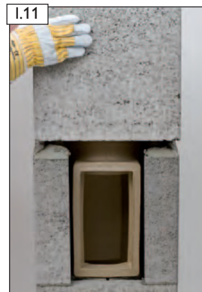
I.11 Vorgeädämten Mantelstein in Mörtel MG(M5) Ila (Mauermörtel nach EN 998-2) versetzen.
