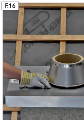
F16 Beilagenscheiben und Flügelmuttern auf den beiden Befestigungsbolzen der Zuluftabdeckplatte montieren.
