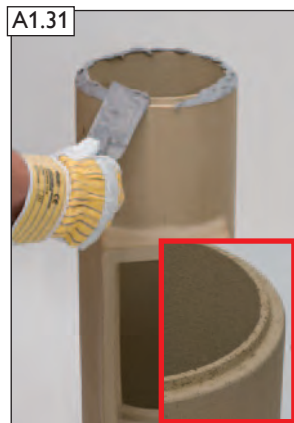
Fugenkitt auf Unterseite Putztüranschluss-Formstück (PA) auftragen.
