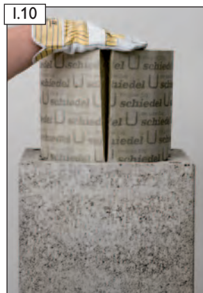
I.10 Dämmplatten biegen, einsetzen und gemeinsam nach unten schieben.
