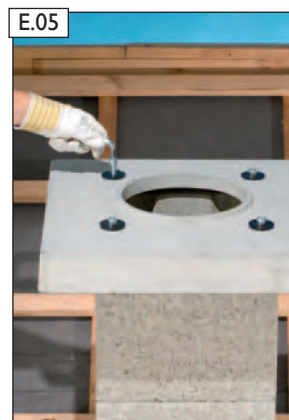
Abdeckplatte kraftschlüssig verschrauben.
