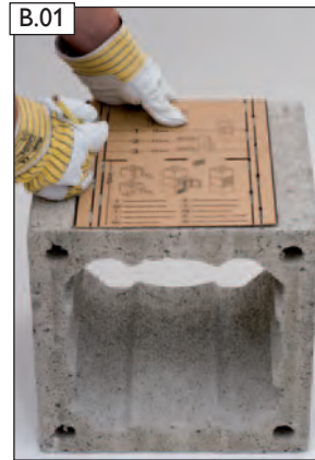
Mantelstein mit RA-Ausschnittschablone anzeichnen. Schablone mittig anlegen.
