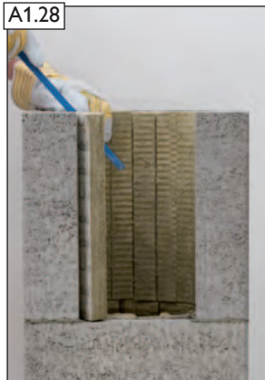
Dämmplatten einbringen und kürzen, Hinterlüftungszellen bleiben frei.
