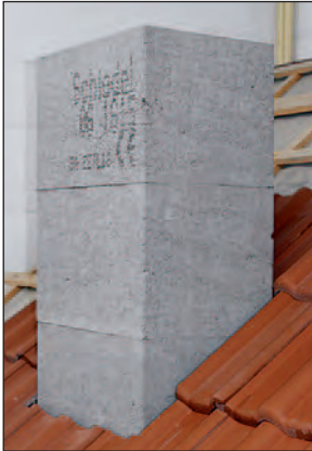
Ansicht vor Montagebeginn.
