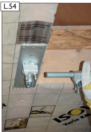
L.54 Gewindestange und 45° Spannwinkel wieder einfädeln und ausrichten.
