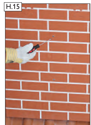
H.15 Gewindestifte kraftschlüssig verschrauben.
