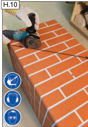
Schrägschnitt mit Flex herstellen.
