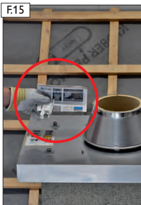
F15 In der Montageanleitung der Edelstahlzuluftkopfplatte befindet sich das Befestigungsmaterial für die optionale Regenhaube „EAGLE“.
