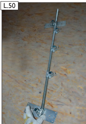
L.50 Zweiten Schornsteinhalter vorbereiten. Spannkreuze und Sparrenhalter lose auf die Gewindestange auffädeln.
