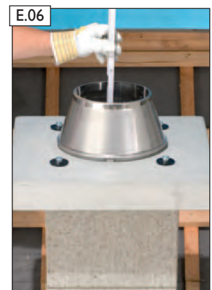
Abströmkonus aufsetzen und fehlende Rohrlänge ausmessen.
