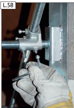
L.58 Spannwinkel an den Schornstein drücken. Abreißschrauben anziehen bis der Schraubkopf an der Sollbruchstelle abreißt.
