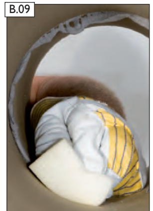
B.09 Fugenkittreste abstreifen.
