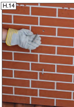
H.14 Gewindestifte in die seitlichen Gewindebuchsen des Stülpkopfes eindrehen.
