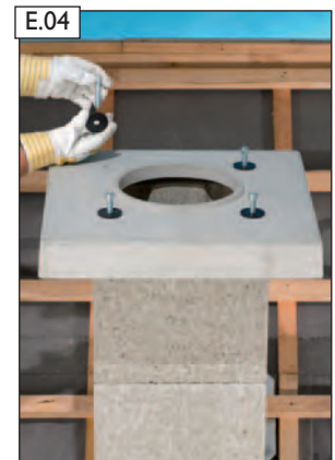
Abdeckplatte aufsetzen. Unterlegscheiben auf Inbusschrauben stecken.
