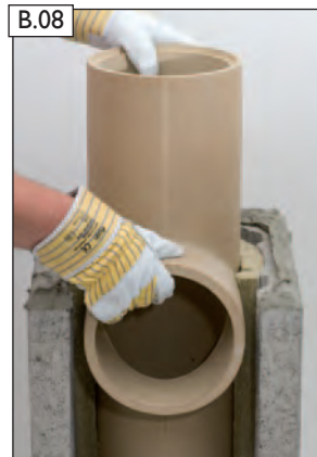
B.08 Rauchrohranschluss-Form- stück versetzen.
