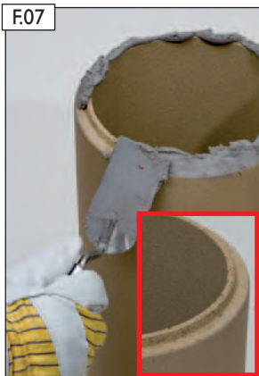
F07 Fugenkitt auf Rohrunterseite auftragen.
