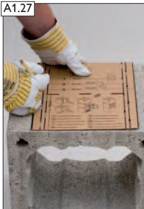
Mantelstein mit Schablone anzeichnen und ausschneiden.
