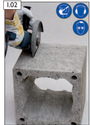
I.02 Mit Winkelschleifer Öffnung herstellen. ACHTUNG! Beachten Sie bitte die Hinweise zum Arbeitsschutz auf Seite 2!
