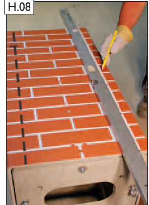
Längenmaß B (zzgl. der ermittelten Aufbauhöhe) an der angezeichneten Mantelsteinabmessung auftragen.
