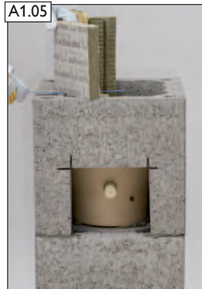
Wärmedämmung einstecken und mit Sägeblatt bündig abschneiden.
