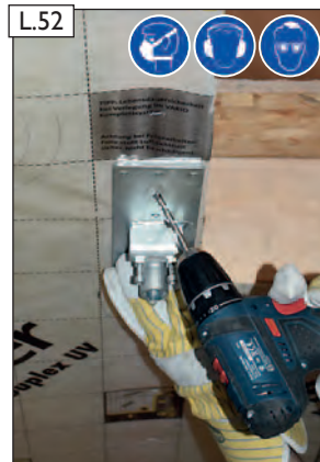
L.52 Sparrenhalter anhalten und Nagellöcher gemäß dem Nagelbild (siehe oben) vorbohren. ACHTUNG! Beachten Sie bitte die Hinweise zum Arbeitsschutz auf Seite 2!
