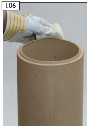
I.06 Unterseite des Putztüranschlusses-Formstückes (PA-Formstück) säubern.
