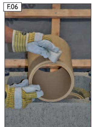
Unterseite des zugeschnittenen Abschlussrohres säubern.
