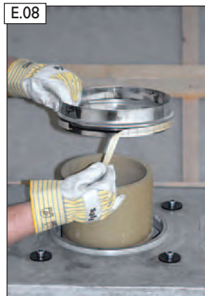
E.08 Am Zentrierring Schutzstreifen des Dichtbandes entfernen.
