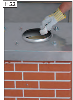
Steckverbindung säubern.
