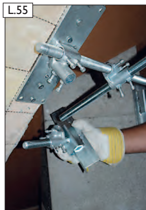
L.55 Gewindestange in Spannkreuze des oberen und unteren Schornsteinhalters einfädeln und dabei das Spannkreuz mit dem 45° Spannwinkel mit auffädeln.
