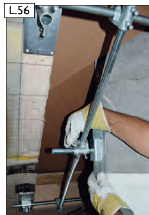
L.56 Spannwinkel ausrichten und vorfixieren.
