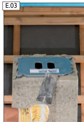
Mörtel MG(M5) Ila (Mauermörtel nach EN 998-2) mit Versetzschaablone auftragen.
