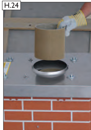
Zugeschnittenes Abschlussrohr versetzen.
