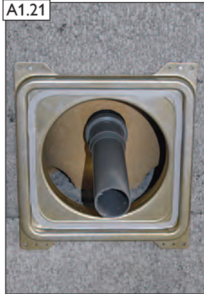
Ansicht fertiger Anschlussübergang.
