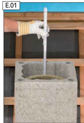
Oberste Dämmplatten enden 8 cm unter der Mantelstein-Oberkante.
