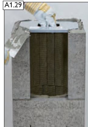
Mörtel MG(M5) IIa (Mauermörtel nach EN 998-2) aufbringen, Schablone verwenden.
