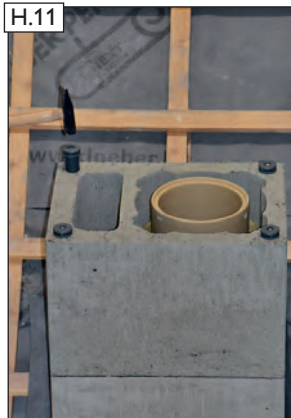
H.11 HEB-Spezialdübel in die Bewehrungskanäle einschlagen.
