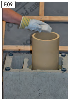
F09 Fugenkittreste abstreifen.
