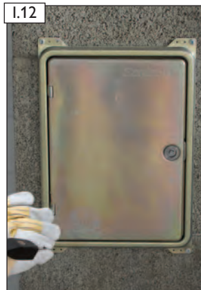
I.12 Abschlussarbeit: Putztür annageln.
