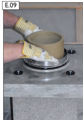
E.09 Zentrierring dicht einsetzen. ACHTUNG! Klebeflächen müssen trocken und sauber sein!
