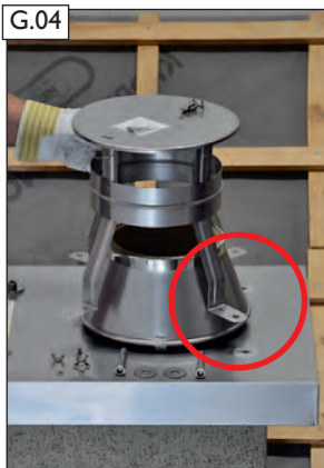
Regenhaube „EAGLE“ auf die Silikondichtungen aufsetzen.
