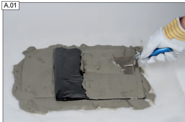
Mörtelbett vorbereiten, Feuchtesperre einlegen, Mörtel MG(M5) Ila (Mauermörtel nach EN 998-2) auftragen.
