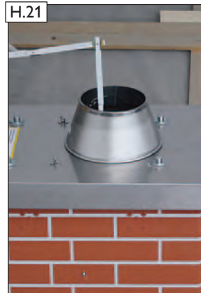
... Zuschnittlänge für das letzte Abschlussrohr ermitteln.
