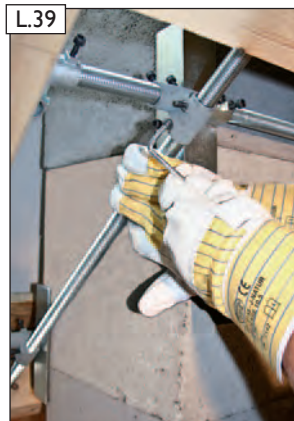
Zuerst Sparrenhalter und Spannwinkel (siehe Bild L.24 und L.25), danach Spannkreuz fixieren. Abreißschrauben anziehen bis Schraubkopf an der Sollbruchstelle abreißt.
