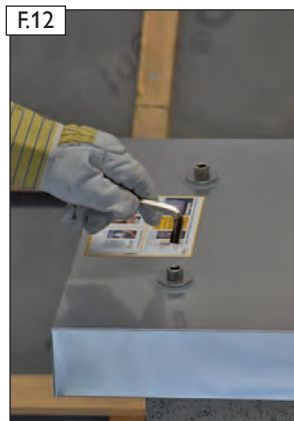
F12 3. Edelstahl-Inbusschrauben M12 handfest anziehen .
