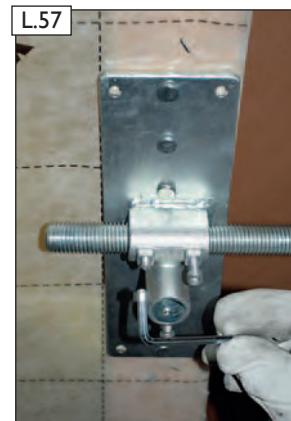
L.57 Gewindestange fixieren. Dazu die Abreißschrauben an beiden Sparrenhaltern mit Inbusschlüssel (F) anziehen bis der Schraubkopf an der Sollbruchstelle abreißt. Erst danach Spannwinkel fixieren (siehe Bild L.58).
