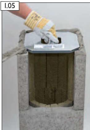
I.05 Mörtel MG(M5) Ila (Mauermörtel nach EN 998-2) mit Versetzsablonen auf Fertigfuß auftragen.
