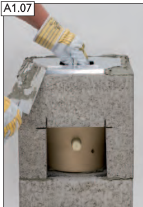
Mörtel MG(M5) IIa (Mauermörtel nach EN 998-2) mit Versetzschaablonen auf Mantelstein auftragen.
