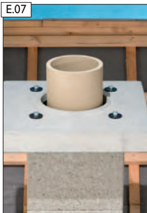
E.07 Schamotterohr zuschneiden und mit Fugenkitt einsetzen.
