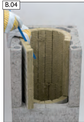
Dämmplatten biegen und einsetzen. Vordere Hinterlüftungszellen freilassen. Dazu Dämmplatten kürzen.
