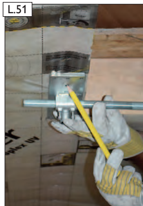
L.51 Aufgefädelte Einzelteile zum einrichten anhalten. Einbauposition für den Sparrenhalter markieren. Danach Einzelteile ausfädeln.
