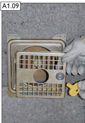
Zulufttürrblatt mit PT-Schlüssel öffnen und aushängen.
