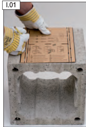
I.01 Mantelstein mit PA-Ausschnittschablone anzeichnen. Schablone mittig anlegen.
