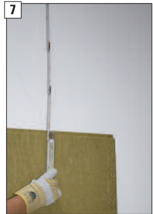
7 Differenzmaß zur bauseitigen Decke ermitteln.
