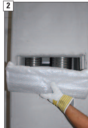
2 Konvektionsluftgitter aus der Montageöffnung entfernen.
