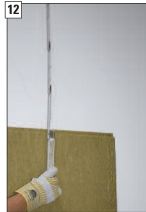
Differenzmaß zur bauseitigen Decke ermitteln.
