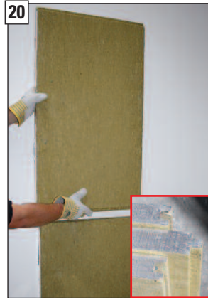
20 Doppelfederplatte in die Nutplatte einstecken und ...
