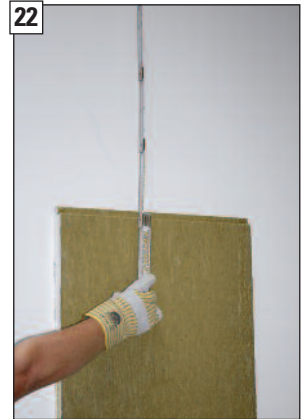
22 Differenzmaß zur bauseitigen Decke ermitteln.
