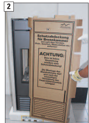
2 Werkseitige Schutzabdeckung entfernen.
