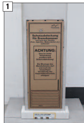
1 Ansicht der werkseitigen Schutzabdeckung nach Beendigung der bauseitigen Veredelungsarbeiten am Feuerstättenmantel.
