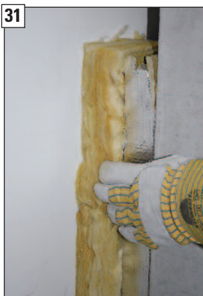
Bauseitige Dämmung zwischen der eingebrachten unteren Nutplatte und der Innenwand einbauen.
