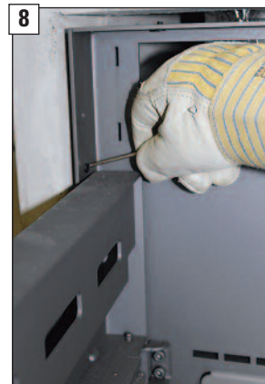
8 Die Feuerraumtür und ...
