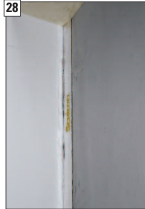
Fertigansicht zum Deckenanschluss.
