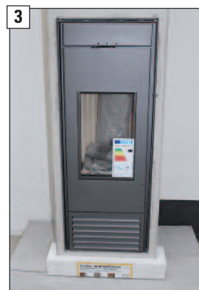
3 Ansicht vor Montagebeginn. HINWEIS! Die umlaufende freie Dehnfuge zum Feuerstättenmantel prüfen!
