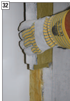
Doppelfederplatte in die Nutplatte einstecken.
