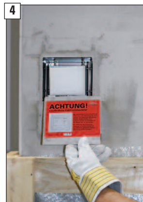
Innere Schutzabdeckung entfernen.
