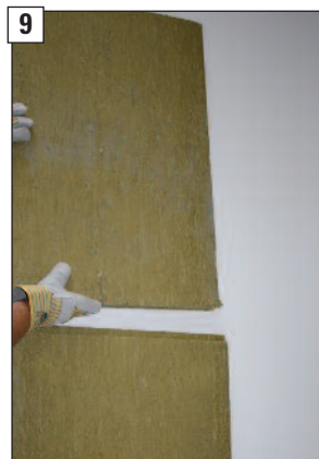
9 Obere Nutplatte in die Doppelfederplatte einstecken.
