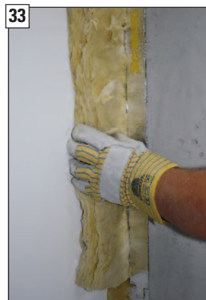
Bauseitige Dämmung zwischen der eingebrachten Doppelfederplatte und der Innenwand einbauen.
