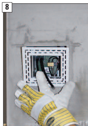
Blende mit Halteklammern auf das Gehäuse der Bedien-/Messeinheit aufstecken.
