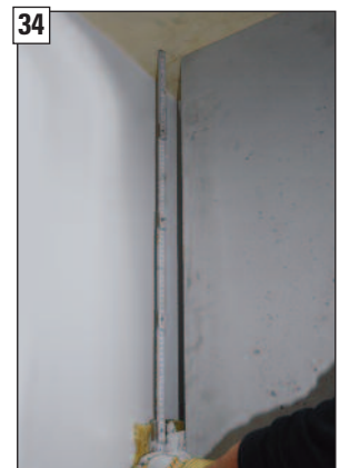
Differenzmaß zur bauseitigen Decke ermitteln.
