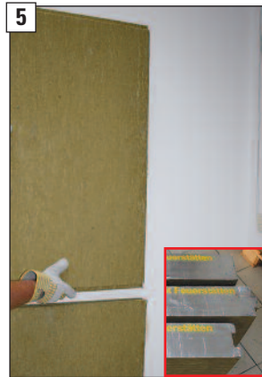
5 Doppelfederplatte in die Nutplatte einstecken und ...
