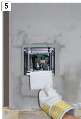
Schutzschwamm entfernen.
