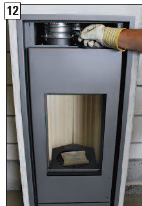
12 Blendrahmen bis zur bauseitigen Verkleidung aufschieben und Befestigungsschrauben umlaufend festziehen.
