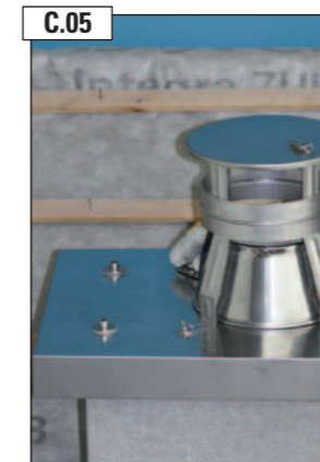
Unterlegscheiben auf Bolzenbefestigung auflegen und die Edelstahlflügelmuttern handfest anziehen.
