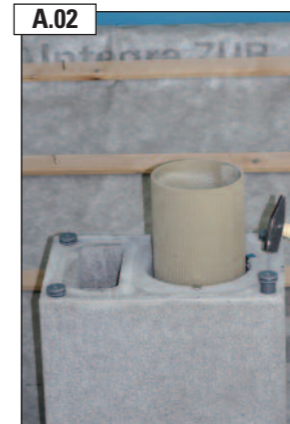
A.02 HEB-Spezialdübel in die Bewehrungskanäle des Mantelsteins einschlagen. HINWEIS: Dies entfällt bei der Verwendung des Befestigungssets „Abdeckwelle“!
