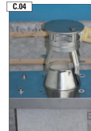
Silikondichtungen auf Zuluftkopfplatte-Edelstahl auflegen. Regenhaube „EAGLE“ aufsetzen.
