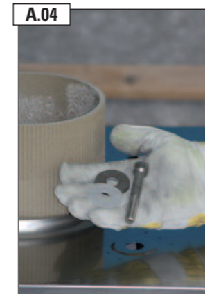
A.04 Montagereihenfolge: 1. Silikondichtungen 2. Edelstahl-Unterlegscheiben 3. Edelstahl-Inbusschrauben M12
