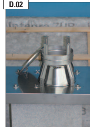
D.02 Der Revisionsdeckel ist mit einer Drahtschlinge, als „Absturzsicherung“, verbunden. Die Drahtschlauenfensicherung mind. einmal im Jahr überprüfen und ggf. erneuern.
