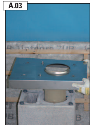
A.03 Zuluftkopfplatte-Edelstahl auflegen.
