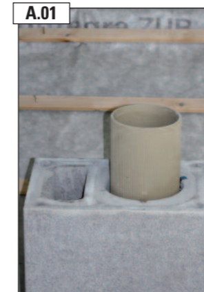
A.01 Rohrüberstand ermitteln. Die Maße gemäß der ABSOLUT-Montage-Versetzanleitung ermitteln (siehe Punkt Mündungsausführung).
