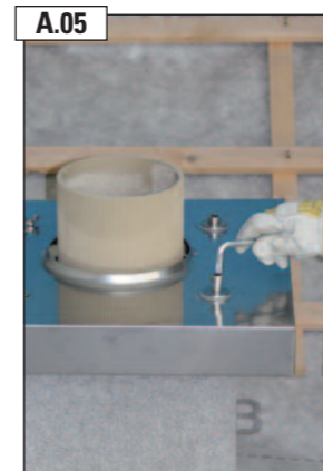
A.05 Inbusschrauben handfest anziehen. ACHTUNG! Vermeiden Sie dabei Beschädigungen an den Silikondichtungen!
