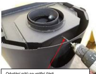
Odvrtání nýtů na vnitřní části
