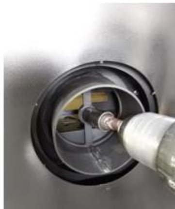
Uchycení přívodu vzduchu šroubem M8
