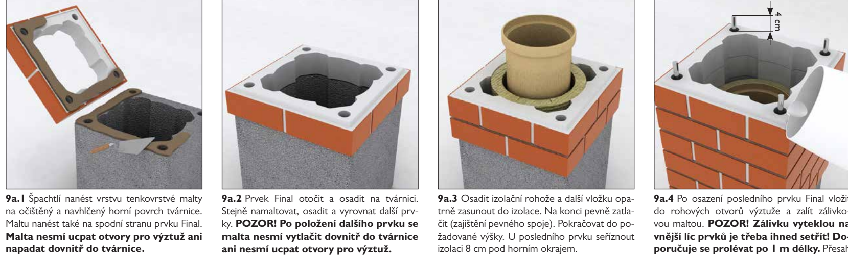
9a.1 Špacíř nanést vrstvu tenkovrstvou maltu na očistěný a navlhčený horní povrch tvárnice. Maltu nanést také na spodní stranu prvku Final. Maltu nesmí ucpat otvory pro vývězu ani napadat dovnitř do tvárnice. 9a.2 Prvek Final otáčí a osadí na tvárnici. Stejně namalovat, osadit a vyrovnat další prvky. POZOR! Po položení dalšího prvku se maltu nesmí vytřít dovnitř do tvárnice ani nesmí ucpat otvory pro vývězu. 9a.3 Očistit izolační rohové a další vložky opatrně zasunut do izolace. Na konci pevně zafixovat (zajištění pevného spoje). Pokračovat do požadované výšky. U posledního prvku seřadit izolaci 8 cm pod horním okrajem. 9a.4 Po osazení posledního prvku Final vložte do rohových otvorů vývězu a zalit zátkovou maltou. POZOR! Zátkovou vložkou na vnější líc prvku je třeba ihned seřadit! Doporučuje se prořezat po 1 m délky. Přesah závěsné tyče nad posledním prvkem Final 4 cm.
