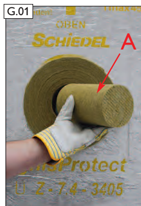
Montážní uzávěr prostupu IGNIS-PROTECT (A) musí během montáže zůstat uvnitř segmentu!
