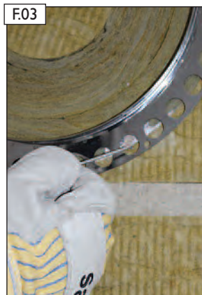
Okapový límec připevněte pomocí hřebíků z korozi-vzdorné oceli
