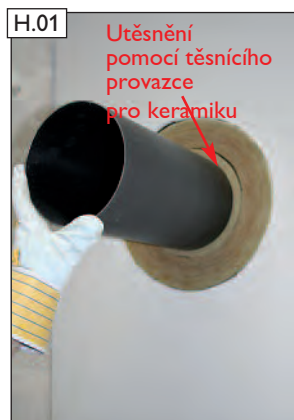
T450 Příklad provedení s jednovrstvým kouřovodem
