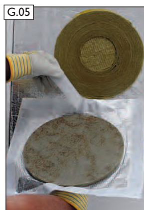
Odstraňte svrchní lepicí pásky. IGNIS-PROTECT BlowerDoor kryt nasadte přes vnitřní segmenty tak, aby přesahující část vnitřního segmentu lícovala s kruhovým izolačním dílem na krytu (viz podrobné znázornění na obr. G.08 a G.09).
