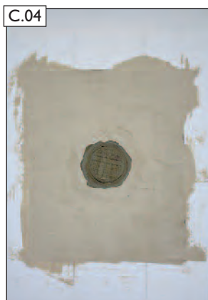
Pohled na provedený stěrkový nátěr.
