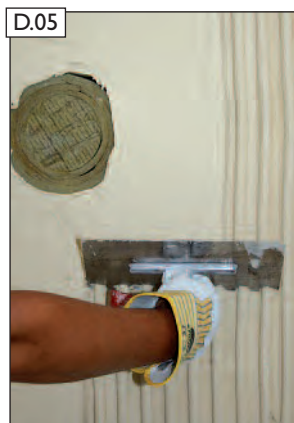
Pomocí zubové stěrky vytvořte požadovanou tloušťku vrstvy.
