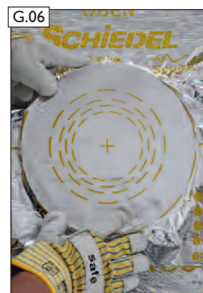
Odstraňte svrchní lepicí pásky. IGNIS-PROTECT BlowerDoor kryt nasadte přes vnitřní segmenty tak, aby přesahující část vnitřního segmentu lícovala s kruhovým izolačním dílem na krytu (viz podrobné znázornění na obr. G.08 a G.09).
