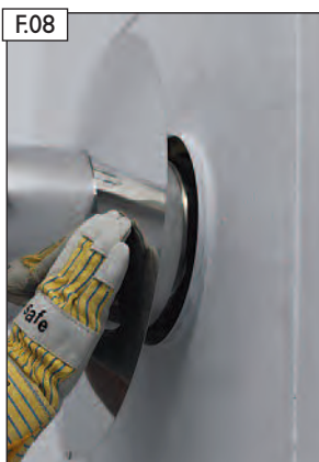
Podle montážního návodu nainstalujte kouřovod.
