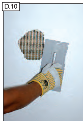
Vytvořte strukturu vrchní omítky.
