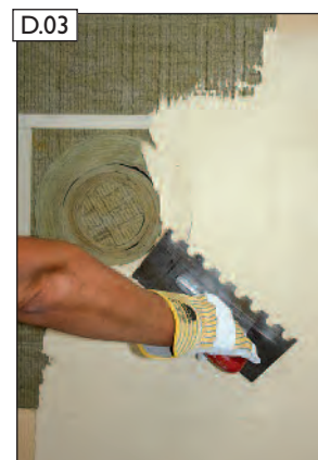
Tlakový stěrkový nátěr naneste pouze na vnější straně IGNIS-PROTECT. POZOR! Na vnitřní hliníkovou část nenanášejte.
