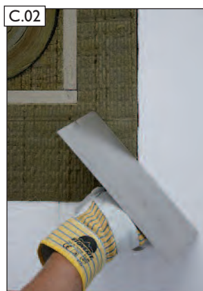
Ověřte, zda je tepelná izolaci osazena do roviny.
