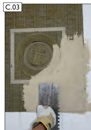
Tlakový stěrkový nátěr naneste pouze na vnější straně IGNIS-PROTECT. POZOR! Na vnitřní hliníkovou část nenanásejte.
