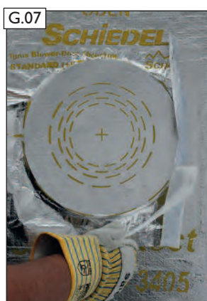
Postupně odstraňte zbývající lepicí pásky a přesahující část vnitřního segmentu zalícujte s kruhovou izolací na krytu.
