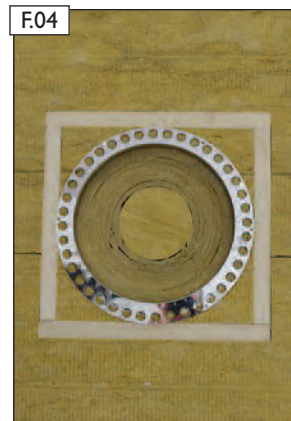
Před nanesením tlakové stěrky ještě jednou ověřte zarovnání okapového límce do správné středové polohy.
