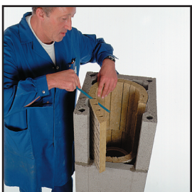
17 Поставете следващите листове топлоизолационна вата. Изрежете излишните части при отвора.
