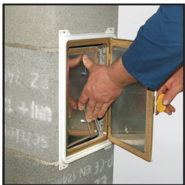
25 Преди измазване на комина поставете вратичката за почистване и проверете функционирането и.
