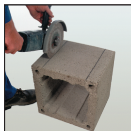
15 Изрежете отвор върху следващото коминно тяло, в което ще се полага тръбата за връзка за димния канал.
