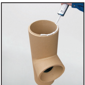
19 Нанесете кит по ръба на керамичната тръба с връзка за димния канал.
