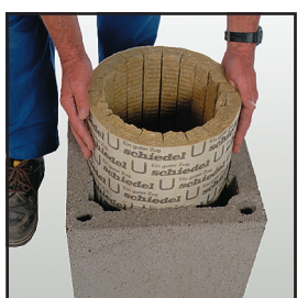
13 В следващото коминно тяло поставете топлоизолационната вата и монтирайте заедно с нея.
