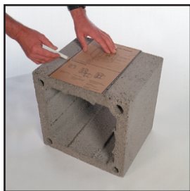
7 На следващото бетонно тяло изрежете отвор с ширина 22 см и го поставете върху първото.
