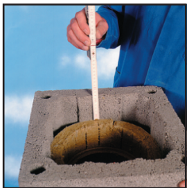
23 Последната керамична тръба трябва да свършва на 10 см от върха на последното бетонно тяло. За целта отрежете необходимата дължина от тръбата.
