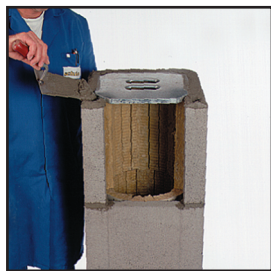
9 Поставете хоросан за слепване на коминното тяло, като поставете шаблона, с който да предпазите отворите за вентилация на ватата.
