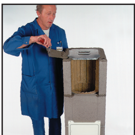
18 Нанесете хоросан за зидане на следващото коминно тяло.
