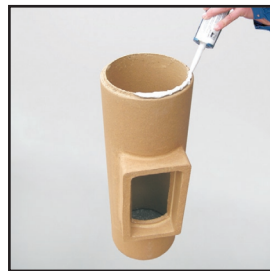
10 Вземете тръбата с отвор за вратичка и уточнете кой е първият ръб за монтиране. Почистете го от прах и навлажнете. Нанесете кит по ръба.
