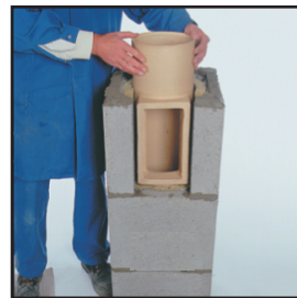
11 Обърнете тръбата за ревизия на комина, като женската част от края на тръбата трябва да е отгоре.
