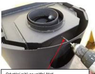
Odvrtání nýtů na vnitřní části
