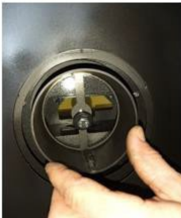
Ukázka montáže, uchycení přívodu vzduchu
